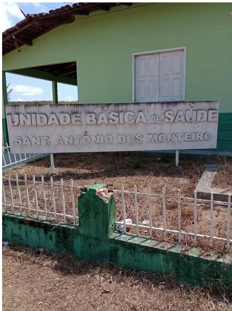
Figura 48: Unidade de Saúde da Vila dos Monteiro
