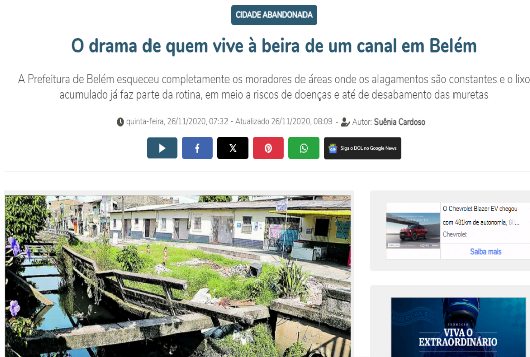
Figura 26 - Reportagem relativa às condições de degradação do Canal da Gentil.
