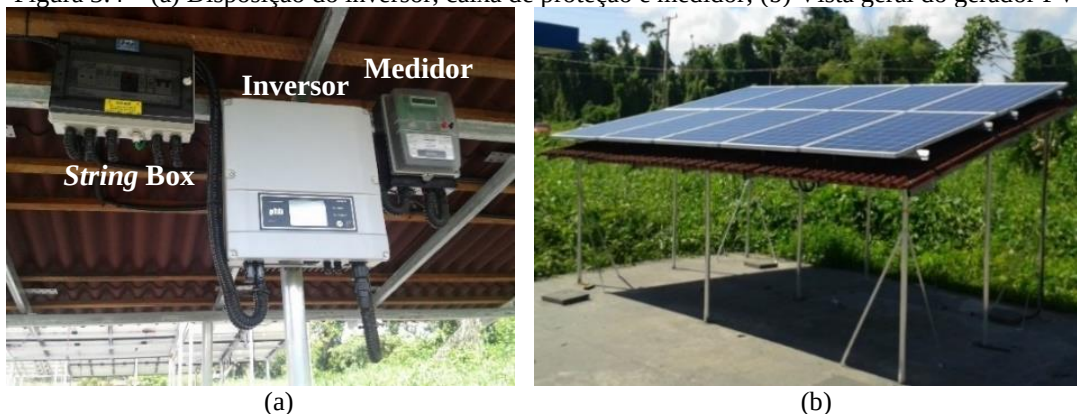
Figura 3.4 – (a) Disposição do inversor, caixa de proteção e medidor; (b) Vista geral do gerador FV.
