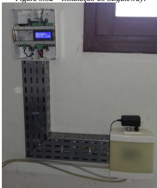
Figura 3.32 – Instalação do SEgateway .
