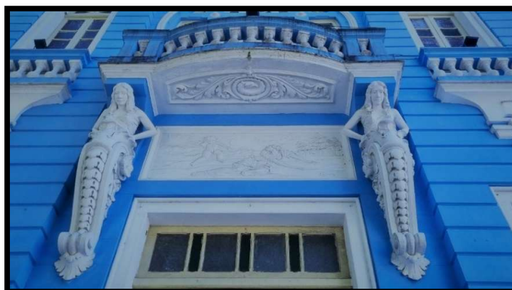
Figura 63 – Detalhe da fachada do prédio da APAE-Belém, 2023
