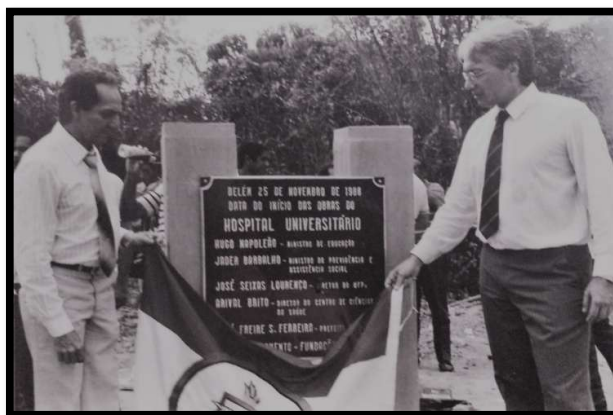
Figura 97 – Início das obras do Hospital Bettina Ferro de Souza, 1988
