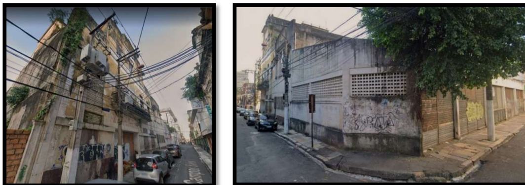
Figura 48 – Prédio abandonado da Escola de Engenharia do Pará, em 2022
