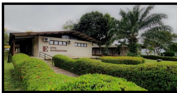
Figura 119 – Antigo pavilhão de aulas atualmente, 2023
