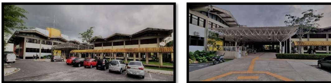
Figura 91 – Biblioteca Central da UFPA, 2023
