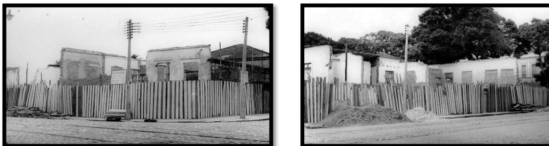
Figura 13 – Obras da sede da Faculdade de Farmácia, déc. 1960
