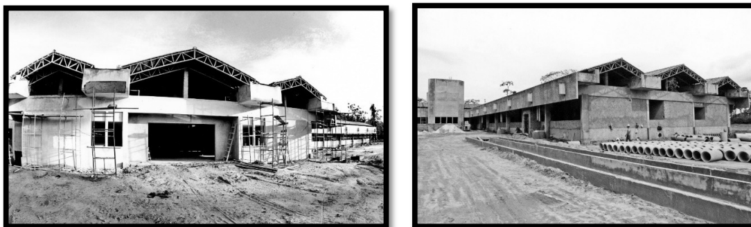
Figura 101 – Obras avançadas do hospital da UFPA, déc. 1990
