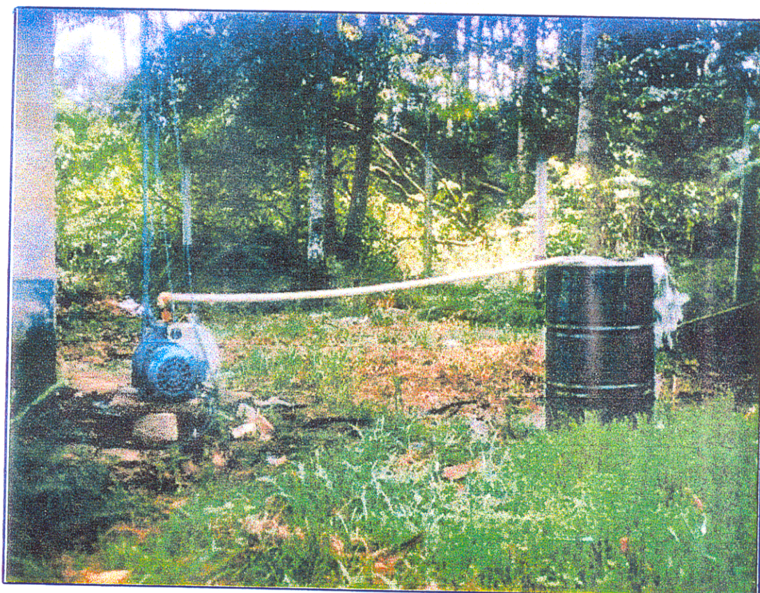
Figura 07: Ensaio de Bombeamento no Poço P0.
