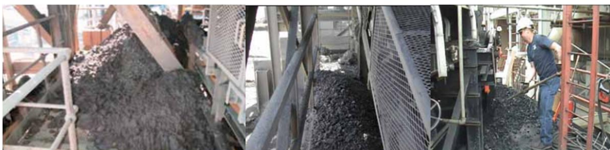
Figura 2.16 - Derramamento de material causado pelo desalinhamento
