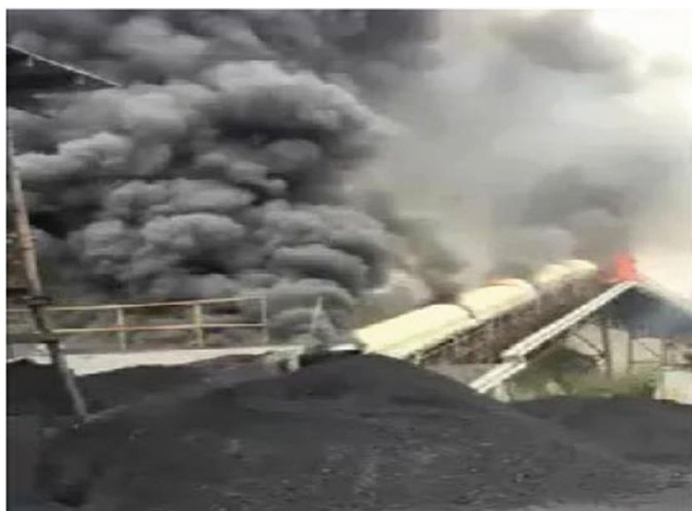
Figura 2.17 - Incêndio por atrito da correia. Fonte: Zhang e Wei, 2023.
