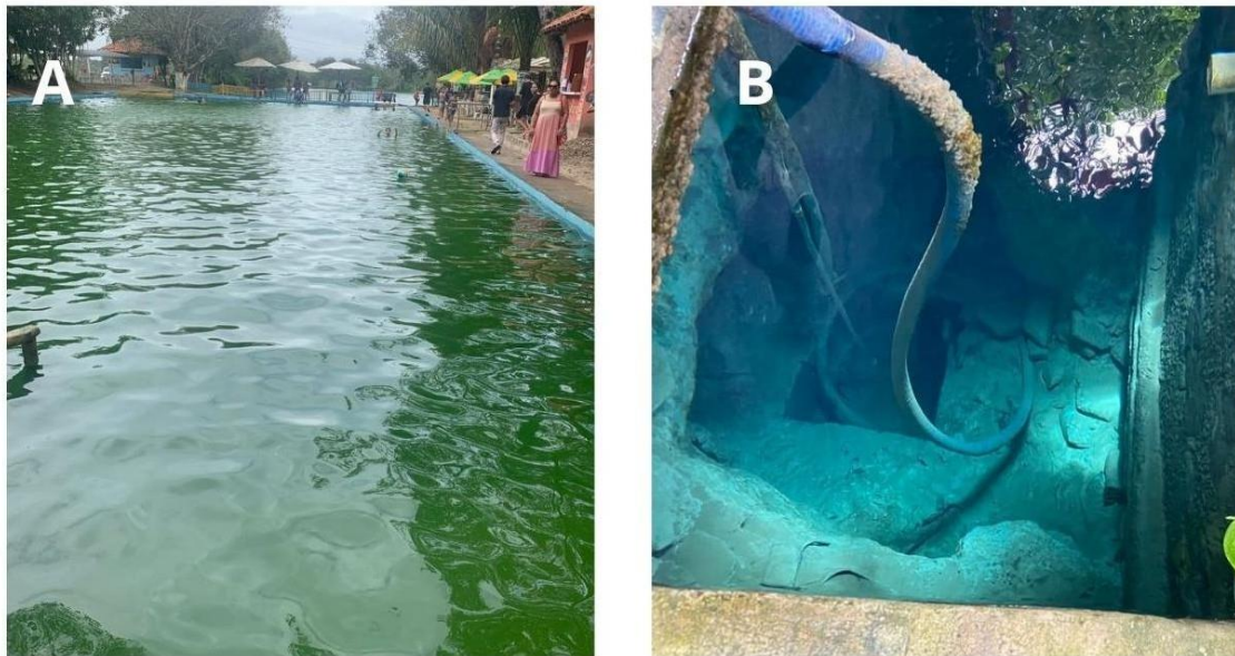
Figura 7- Estruturas impermeabilizantes instaladas no Igarapé 3 (IG-3), localizado no município de Ananindeua, PA.
