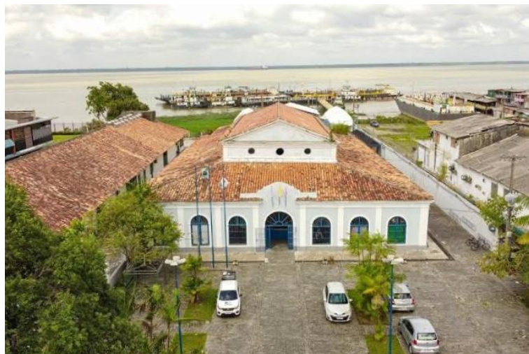
Figura 04- Vista aérea do Prédio do Curro Velho atualmente
