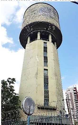
Figura 7 - Reservatório Elevado Desativado – 3º Setor
