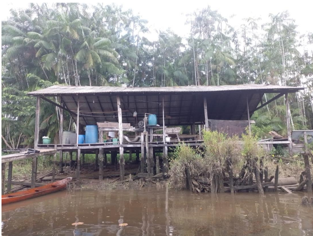
Figura 19 – Casa de Farinha de D. Francisca Sá, na beirada do Rio Mucutá (Vista externa)
