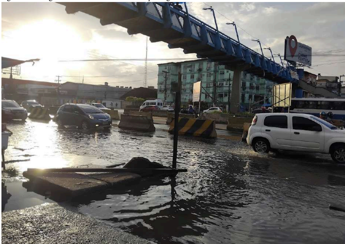
Figura 15 – Alagamento em trecho da BR-316 após alguns minutos de chuva.
