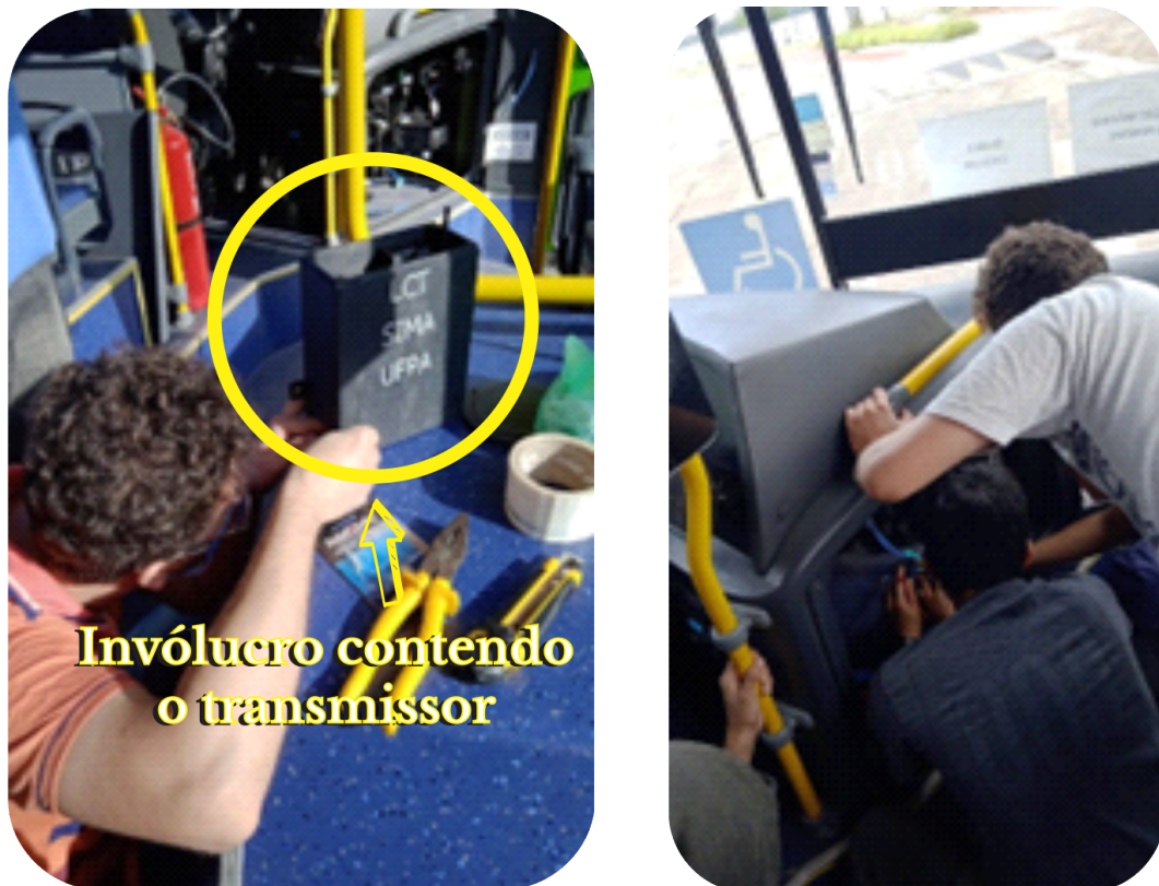
Figura 54 – Instalação do End-node do transmissor do Ônibus Circular
