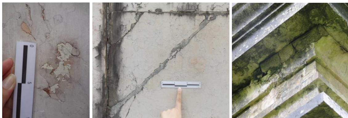
Figura 62: Exemplos de preenchimento de lacunas e fissuras em túmulos do Cemitério da Soledade.
