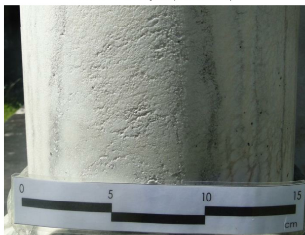
6- DESINTEGRAÇÃO (SUGARING)
