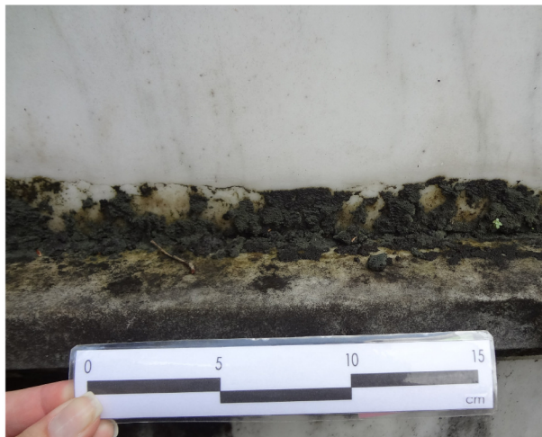
4- CARBONIZAÇÃO/DANO MECÂNICO - ARRANHÃO
