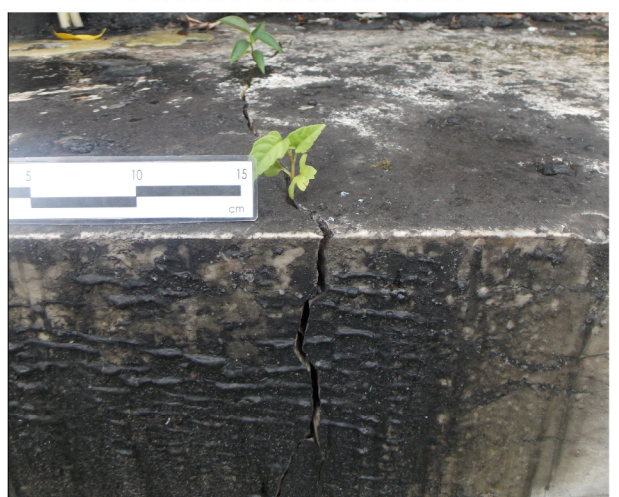
5- FRATURA/ DEPÓSITO/ PLANTA
