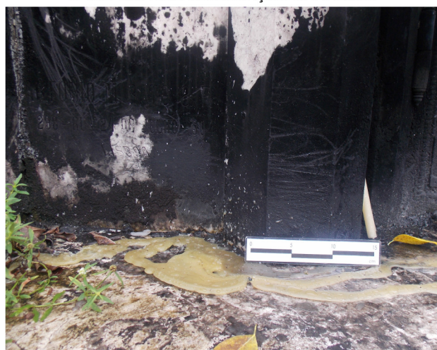
5- FRATURA/ DEPÓSITO/ PLANTA
