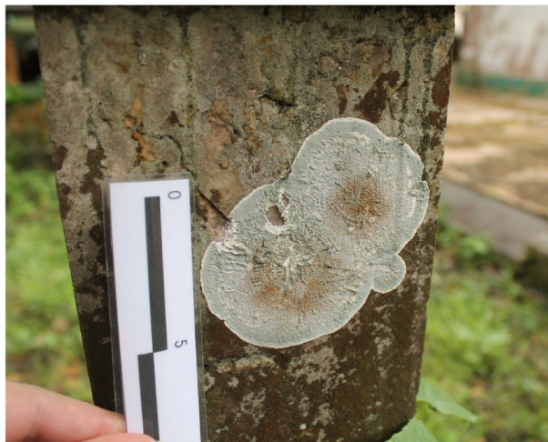
4- FISSURAS CAPILARES/ FILME INORGÂNICO
