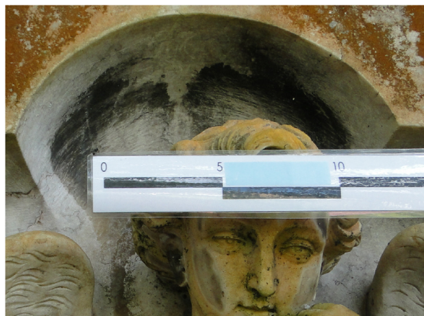
1- DANO MECÂNICO-ARRANHÃO
