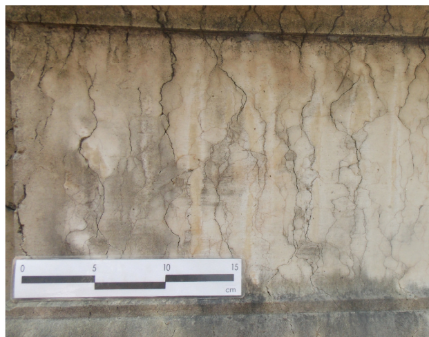
3- FISSURAS/ PREENCHIMENTO
