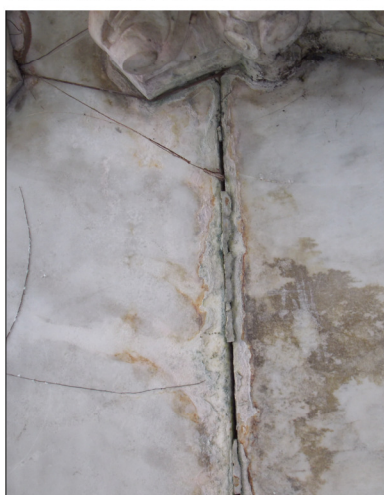
5- DESTACAMENTO/PREENCHIMENTO
