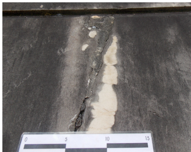
3- DEPÓSITO/CARBONIZAÇÃO/ ARRANHÃO
