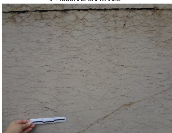
6- FISSURAS CAPILARES
