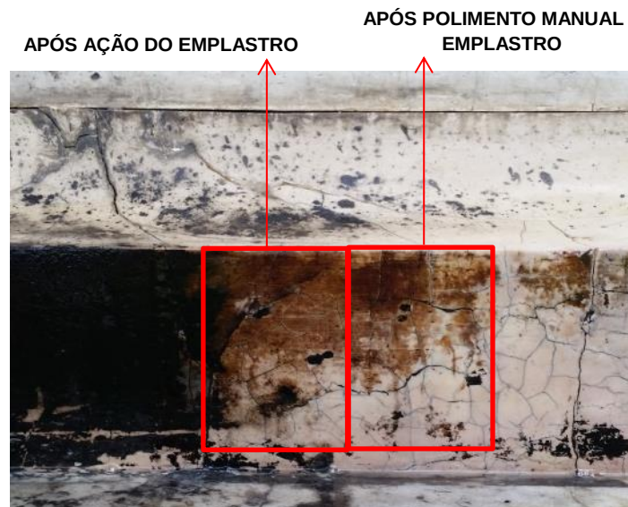
Figura 99: Aspecto final da área analisada após aplicação de emplastro de bentonita e polimento.
