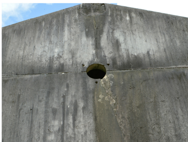
5- FISSURA/PREENCHIMENTO
