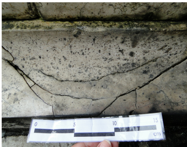
3- CARBONIZAÇÃO/ DANO MECÂNICO- ARRANHÃO
