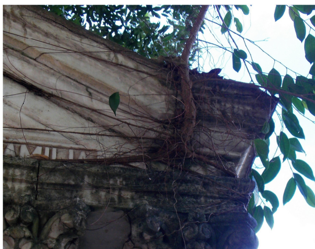
5- DESTACAMENTO/PREENCHIMENTO
