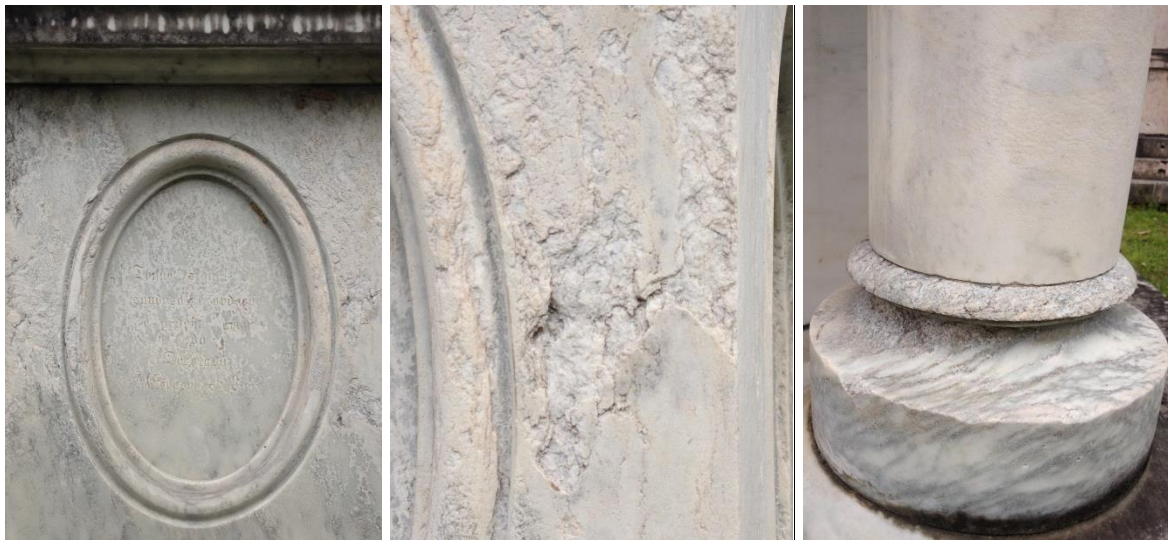
Figura 71: Erosão diferencial no mármore do túmulo G22.
