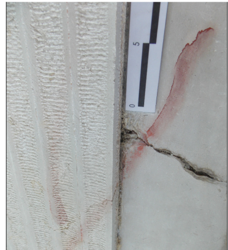
6- FISSURAS CAPILARES
