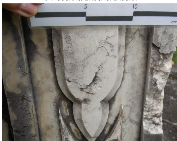
5- FISSURAS CAPILARES/ DEPÓSITO DE SUJIDADES
