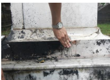
Figura 52: Polimento de área carbonizada.
