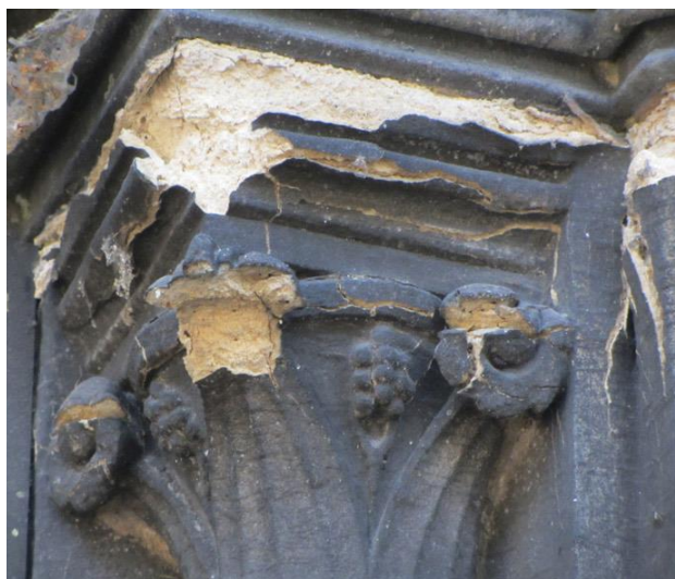
Figura 04: Exemplo de crosta negra em substratos de calcário em área protegida. Fonte: DELGADO RODRIGUES, 2014.
