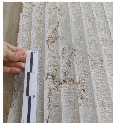
6- FISSURAS CAPILARES
