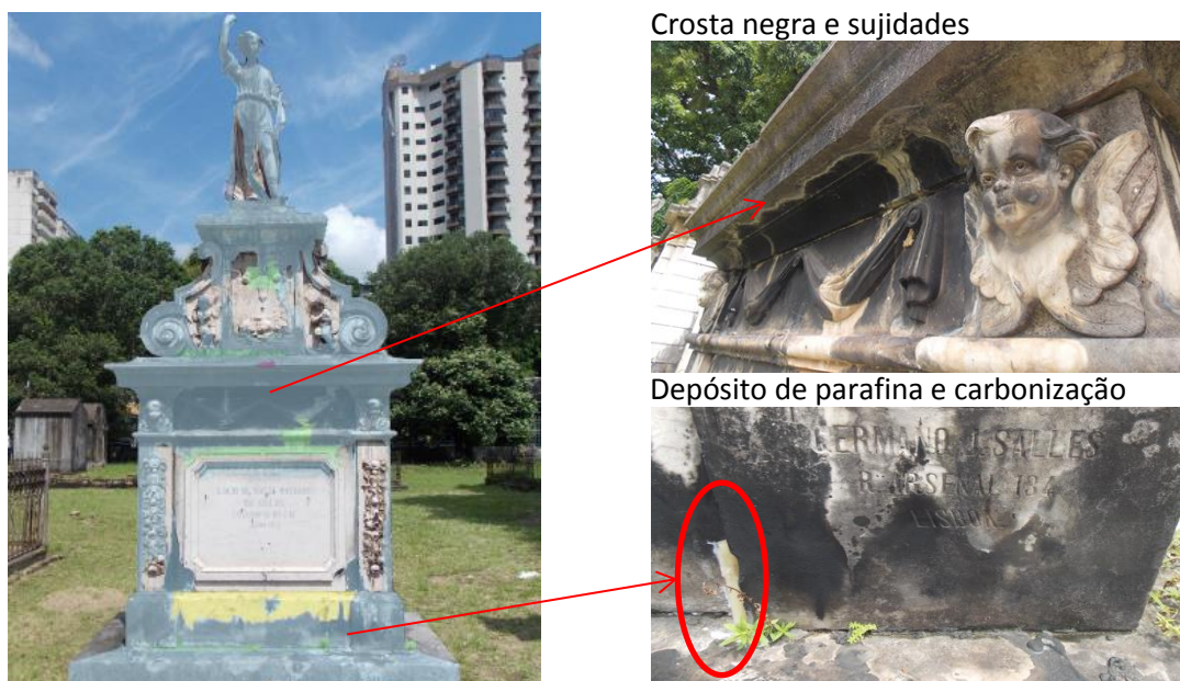
Figura 64: Mapeamento de danos túmulo F36, com destaque para o grupo descoloração e depósito marcado em azul e danos em destaque.
