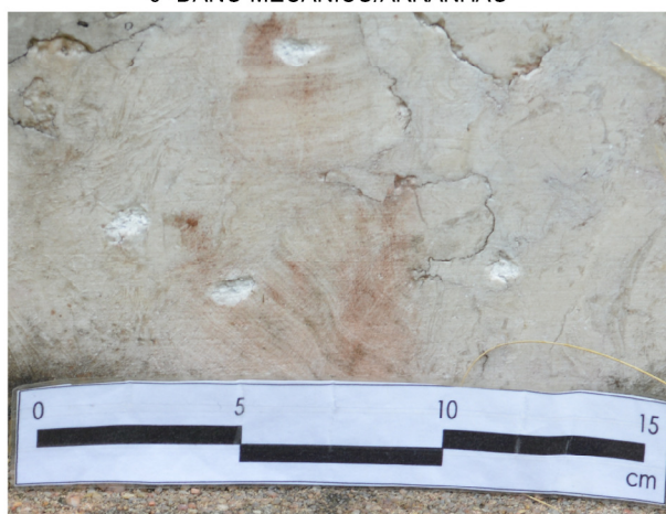
6- DANO MECÂNICO/ARRANHÃO
