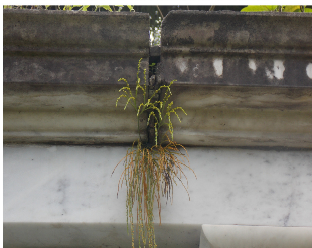
5- DESTACAMENTO/ PREENCHIMENTO/ PLANTA
