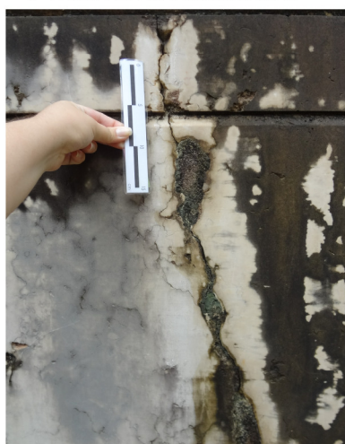
5- FISSURA/PREENCHIMENTO
