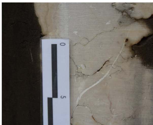
4- DANO MECÂNICO - ARRANHÃO
