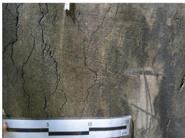
3- FISSURAS CAPILARES
