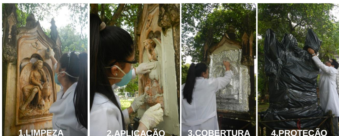
Figura 50: Procedimentos seguidos na aplicação de emplastro de bentonita, com as etapas identificadas.
