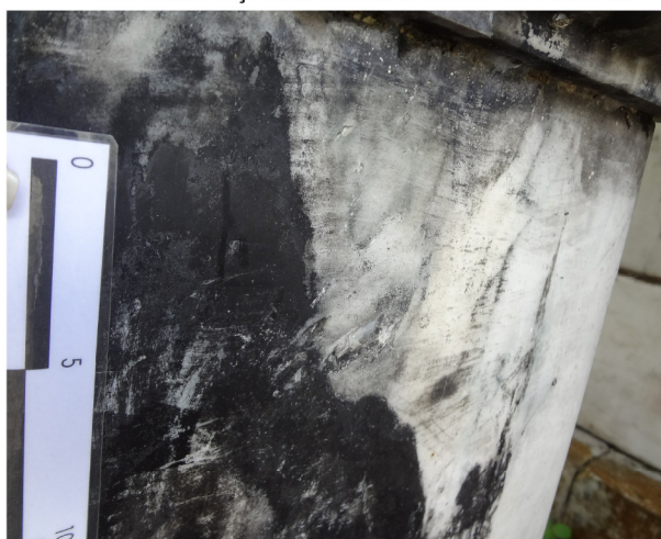
4- CARBONIZAÇÃO/DANO MECÂNICO - ARRANHÃO
