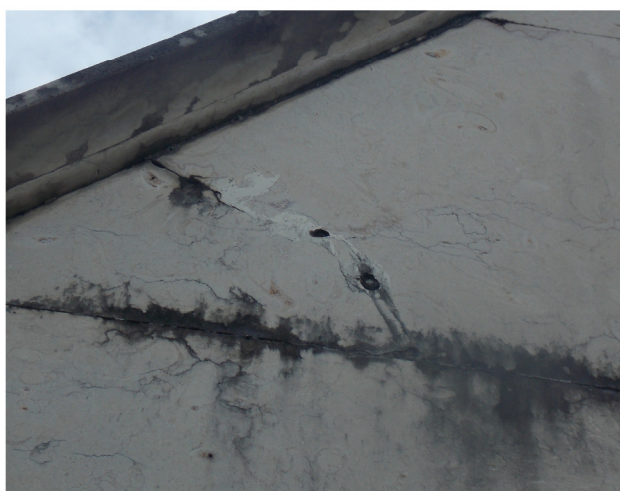
5-FISSURA/PREENCHIMENTO
