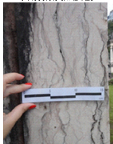
6- FISSURAS CAPILARES
