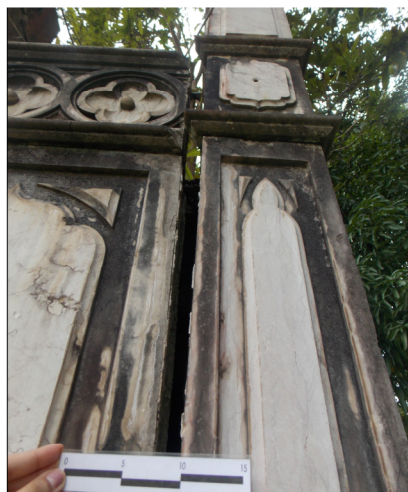
3- FISSURAS/ EROSÃO/ LACUNA
