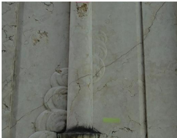
3- FISSURAS CAPILARES
