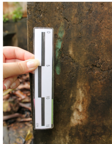
4- FISSURAS CAPILARES/ FILME INORGÂNICO
