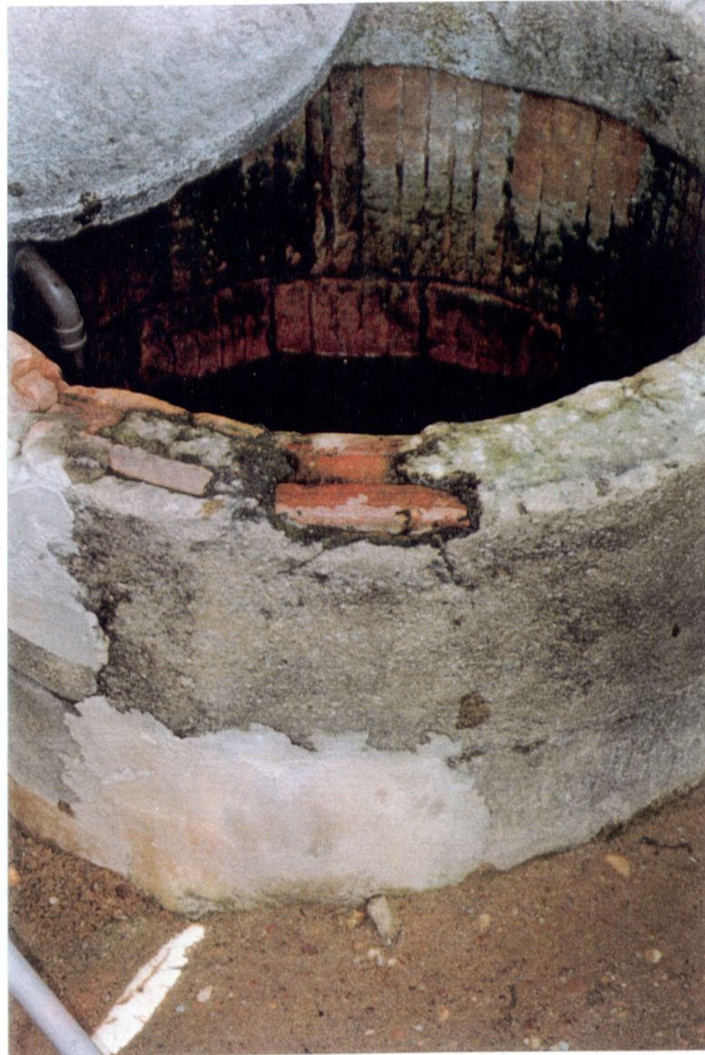
Figura 14 – Poço escavado (E7) utilizado para uso doméstico e para amostragem e determinação das variáveis aqui estudadas. Nota-se que o nível da água neste poço (nível estático do aquífero freático) aflora à superfície do terreno (N.E igual a zero).
