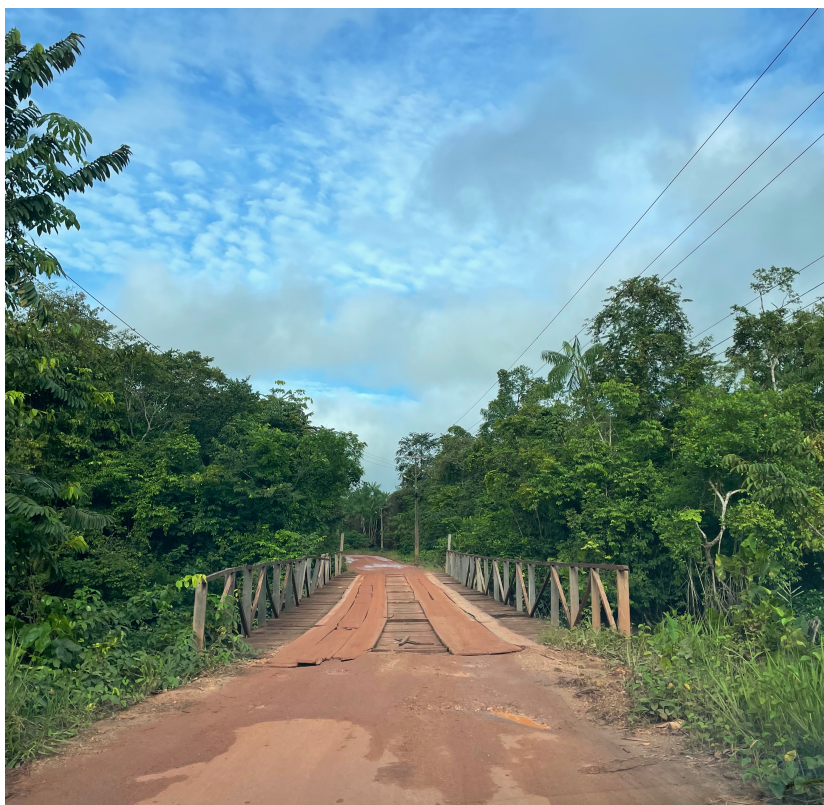
Figura 11 – Ponte para acesso a comunidade Caiçaua em Santa Bárbara do Pará
