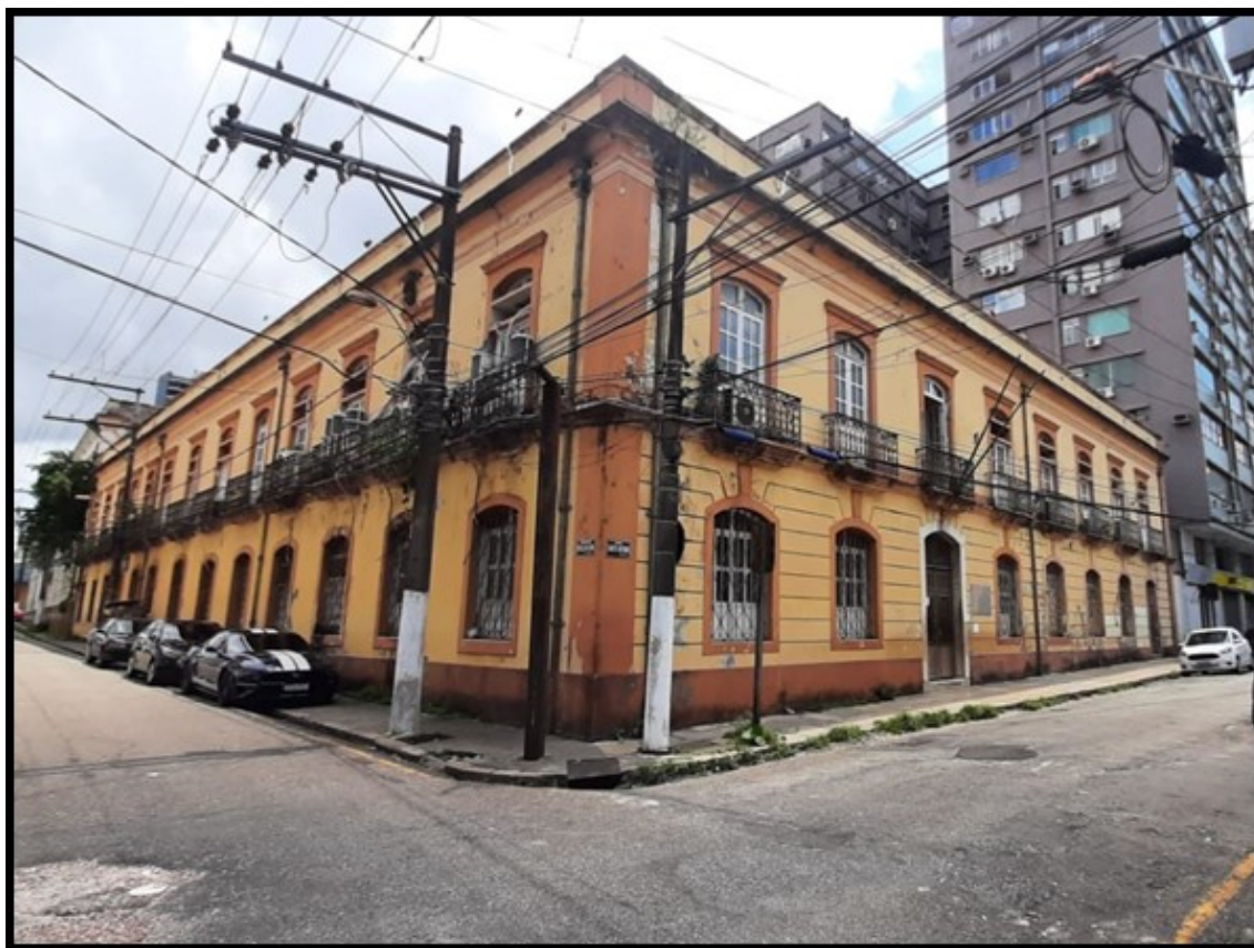
Figura 2: Visão atual do prédio onde funcionava o Colégio Nossa Senhora do Amparo
