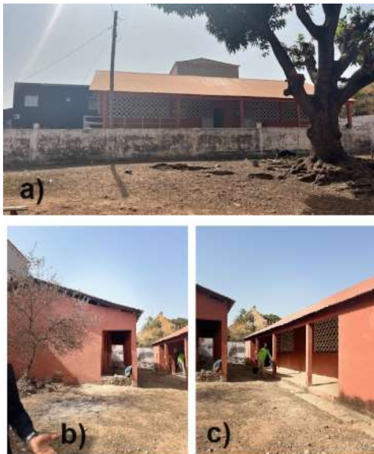
Figura 22 - Estrutura da escola.
