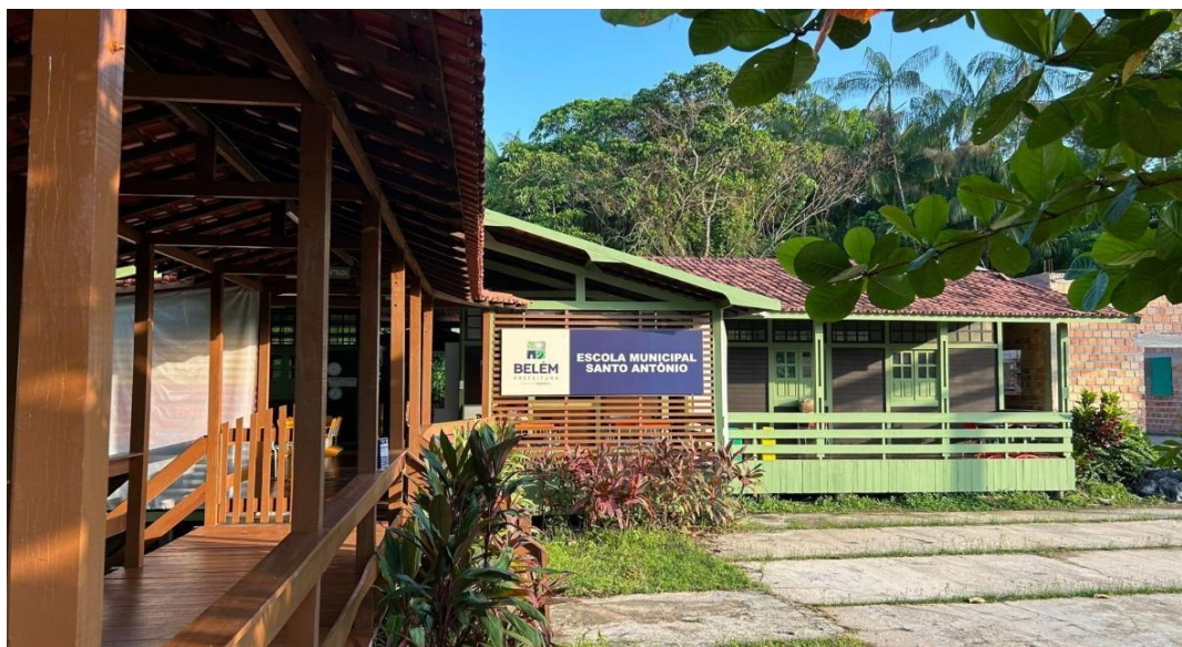
Figura 30 - Estrutura da escola Anexo Santo Antônio.
