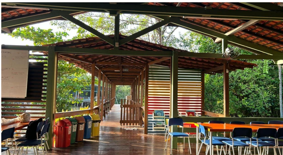
Figura 31- Parte externa com refeitório da escola.
