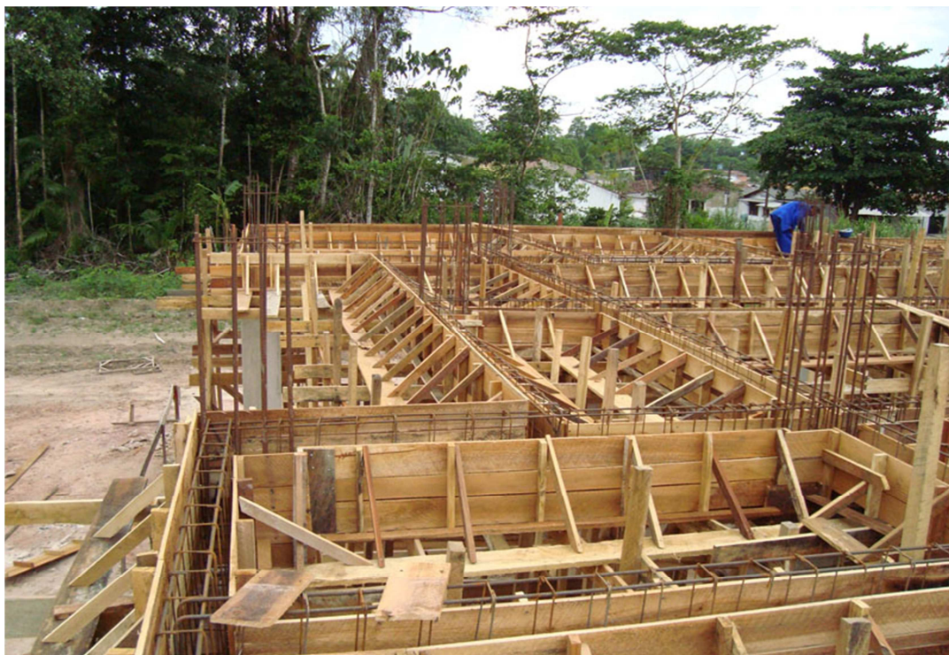
Figura 11 – Montagem das fôrmas e armação das ferragens de pilares, vigas e laje do nível térreo do bloco III.
