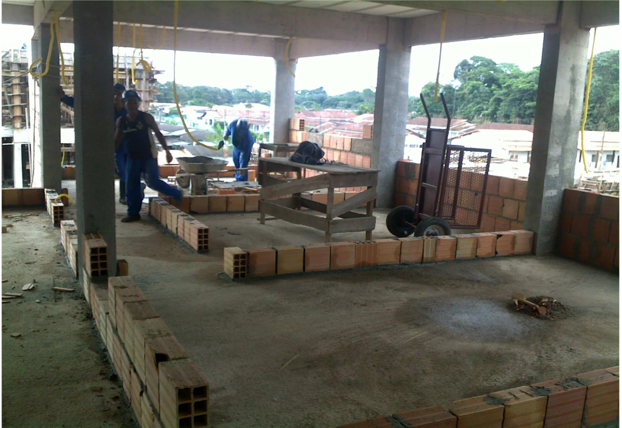
Figura 10 – Montagem de alvenaria de elevação com a aplicação do conceito de célula móvel de produção, denominada de CMP-02.
