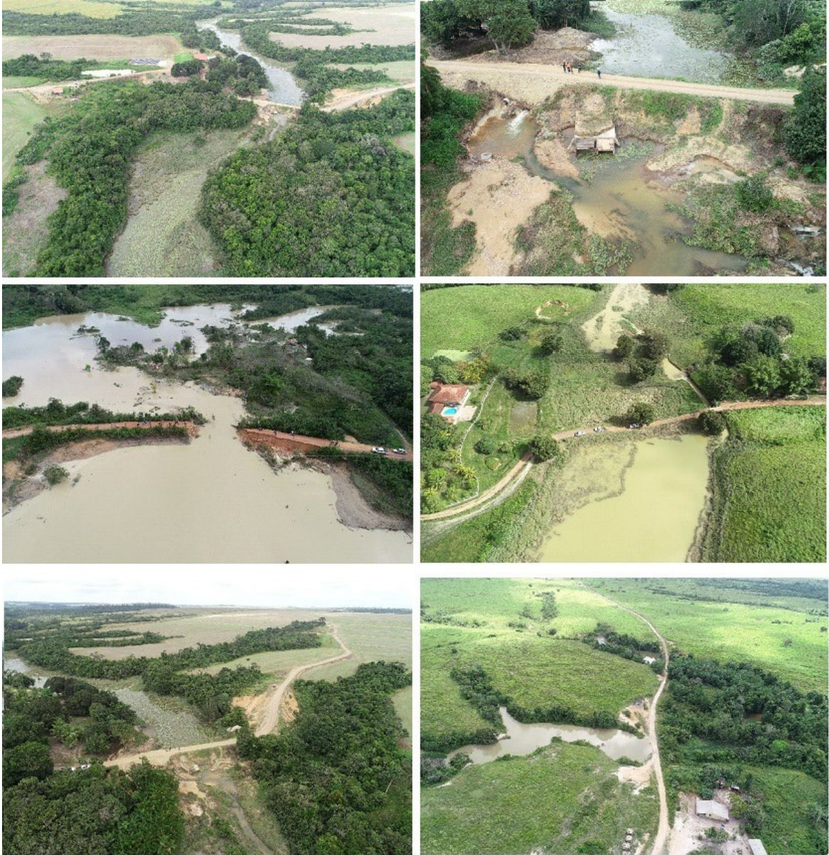
Figura 17 – Fotografias obtidas via ARP/Drone de barramentos e barragens na bacia do rio Uraim.
