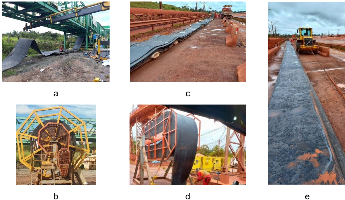
Figura 13. Instalação de uma correia tubular: (a) posicionamento da correia; (b) enrolador de correia; (c) correia posicionada em dobras sobrepostas após sequência de emendas; (d) bobina com a correia a ser instalada; (e) tração da correia utilizando cabo de aço conectado a uma pá carregadeira [5].
