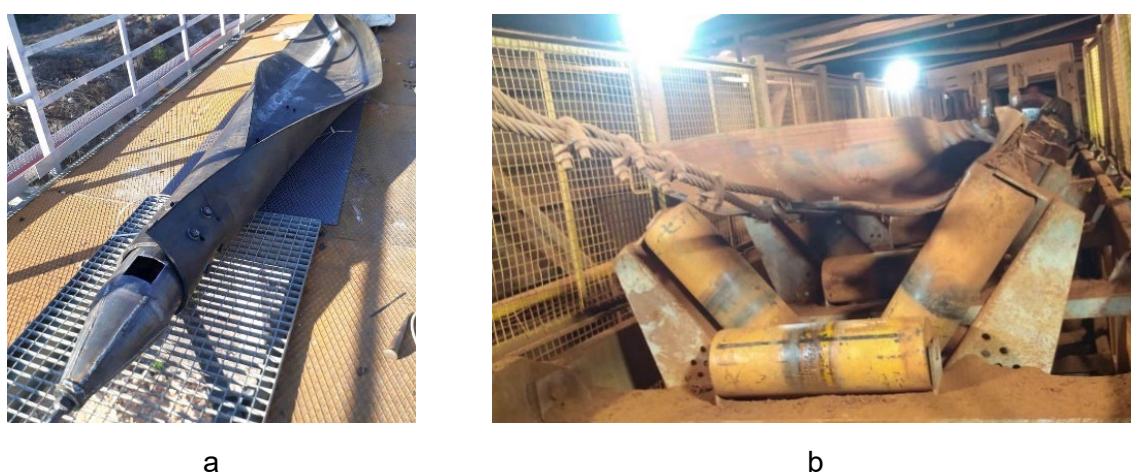
Figura 12. Tração de uma correia tubular durante a instalação: (a) dispositivo em forma de torpedo para instalação; (b) remoção de uma correia avariada após rompimento [5].
