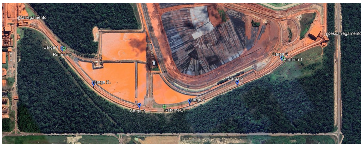
Figura 60. Posicionamento recomendado de unidades de medição para a digitalização do monitoramento da rotação da correia em uma aplicação prática de transportador tubular [59].
