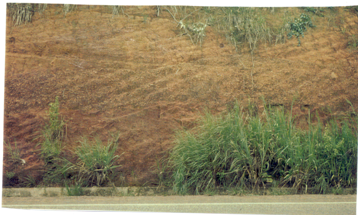
Figura 28 - Stone-layer do Km 63,2 a norte de Açailândia - O contato com o substrato é sub-horizontal, porém, seu topo mostra-se ondulado. Está recoberto pelo capeamento argilo-arenoso.
