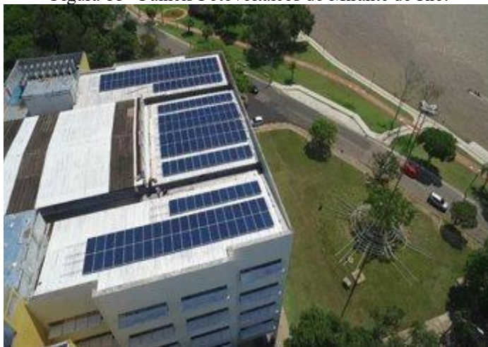
Figura 11 - Painéis Fotovoltaicos do Mirante do Rio.
