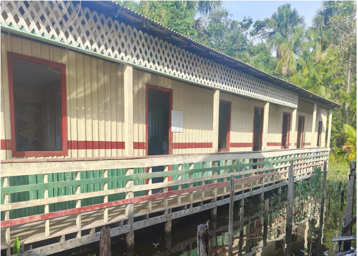
Figura 5 – Vista do prédio anexo da Escola Portugal.
