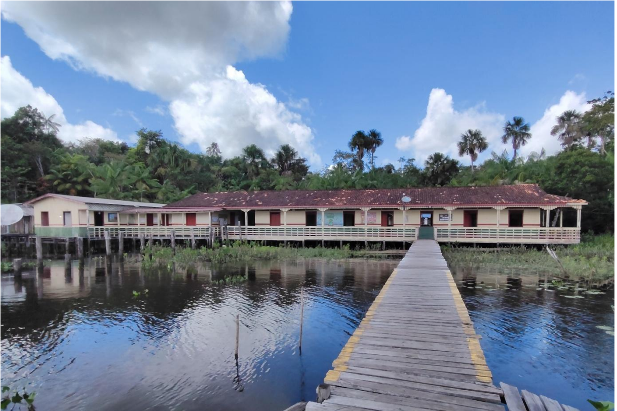
Figura 3 – Vista frontal da escola Portugal.
