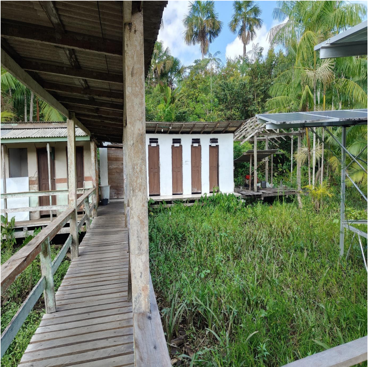
Figura 7 – Passarela de acesso aos banheiros da Escola Portugal.
