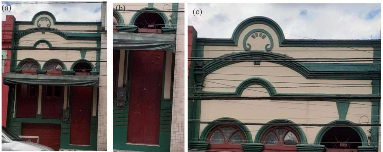
Figura 7: O art nouveau popular em fachada com elementos decorativos e formais simplificados em área de expansão no bairro do Umarizal: (a) Fachada da Trav. Dom Pedro; (b) detalhe decorativo nos desenhos em relevo e sinuoso da porta inspirado nas esquadrias art nouveau ; (c) cornijas e frisos curvos e com desenho em massa simplificado.
