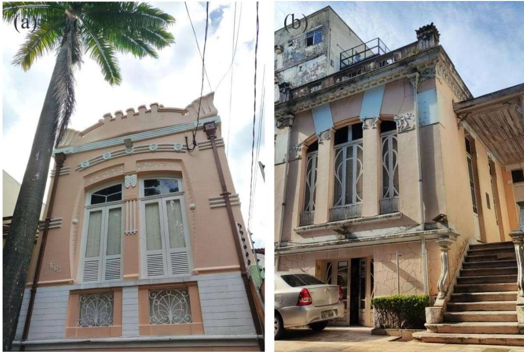
Figura 6: Outras edificações residenciais de menores dimensões, porém ainda representativas de uma sociedade com poder aquisitivo, de fachadas tipicamente art nouveau nos bairros de Nazaré e São Brás: (a) Fachada na Tv 9 de Janeiro, 1663; (b) Fachada da Av. Magalhães Barata, 770;
