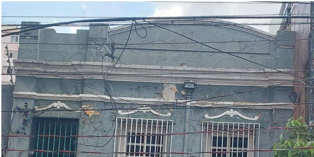
Figura 18 – Detalhe de edificação no bairro do Umarizal, na Rua Curuça, onde se observa a platibanda curva e em assimetria e elementos decorativos florais e curvos simplificados na moldura superior das janelas, identificada como exemplo do Art Nouveau de Apropriação.
