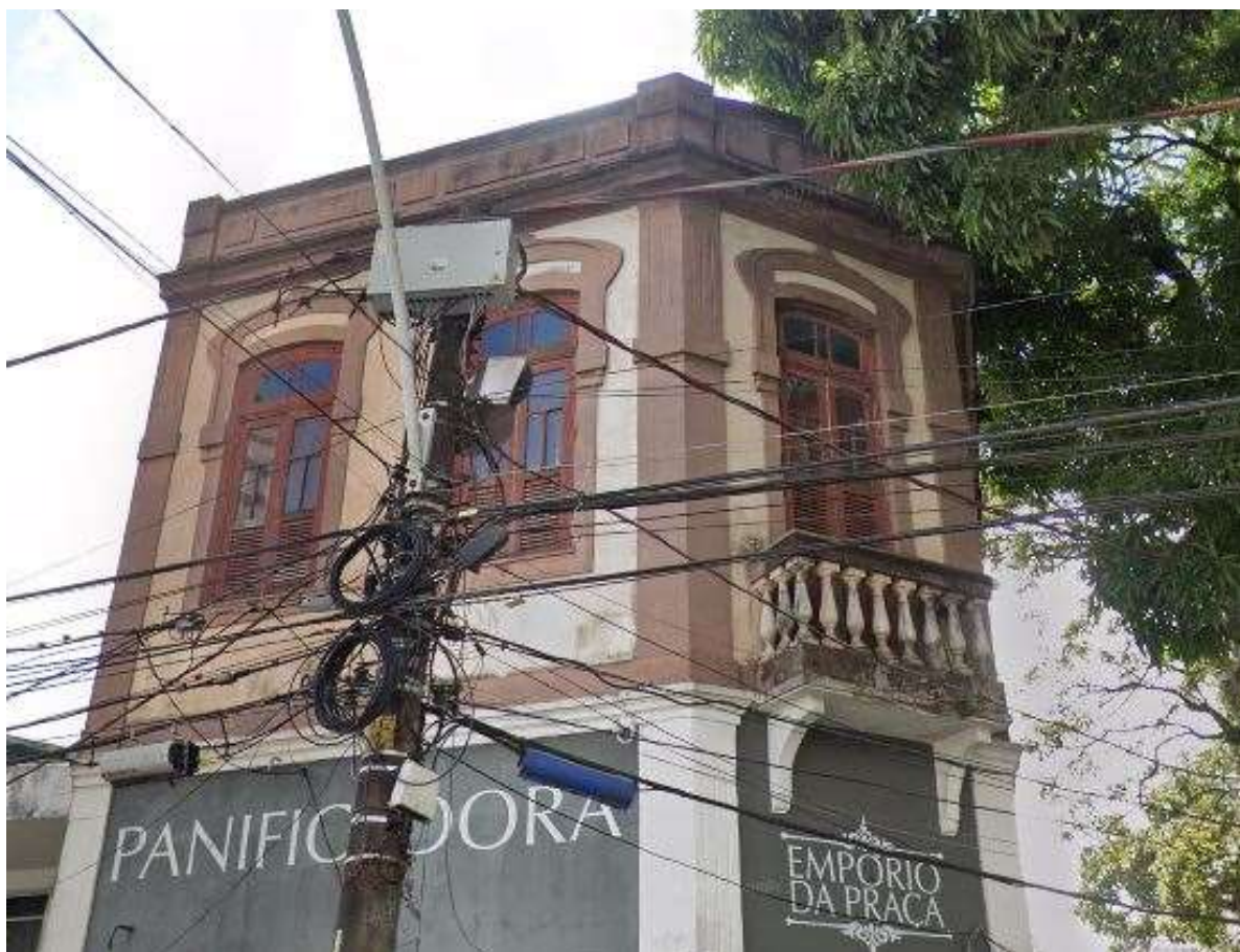
Figura 20 – Edificação no bairro do Umarizal, na esquina da Av. Senador Lemos e Rua da Praça Brasil, onde se observa o pavimento superior ainda preservado e marcado por molduras dos vãos de janelas identificada como exemplo do Art Nouveau de Apropriação
