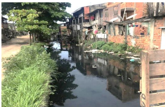
Figura 2 - Lançamento de esgoto na drenagem urbana da Bacia Hidrográfica Estrada Nova.
