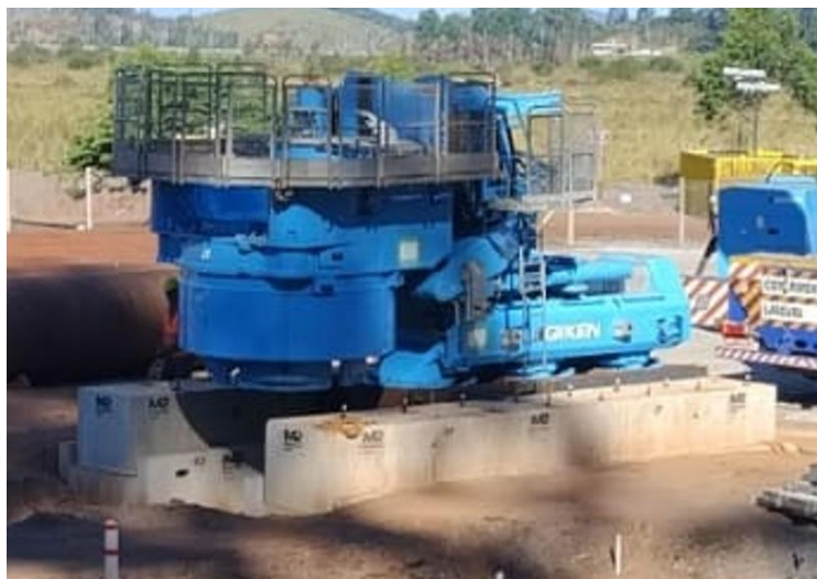
Figura 13– Equipamento posicionado com os contrapesos de concreto pré-moldado para iniciar o processo de cravação.
