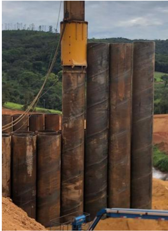
Figura 7– Cravação de estaca metálica com bate estaca.
