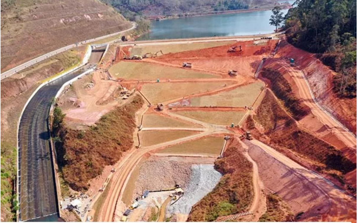
Figura 2– Obras de reforço da Barragem Santana, em Itabira/MG.
