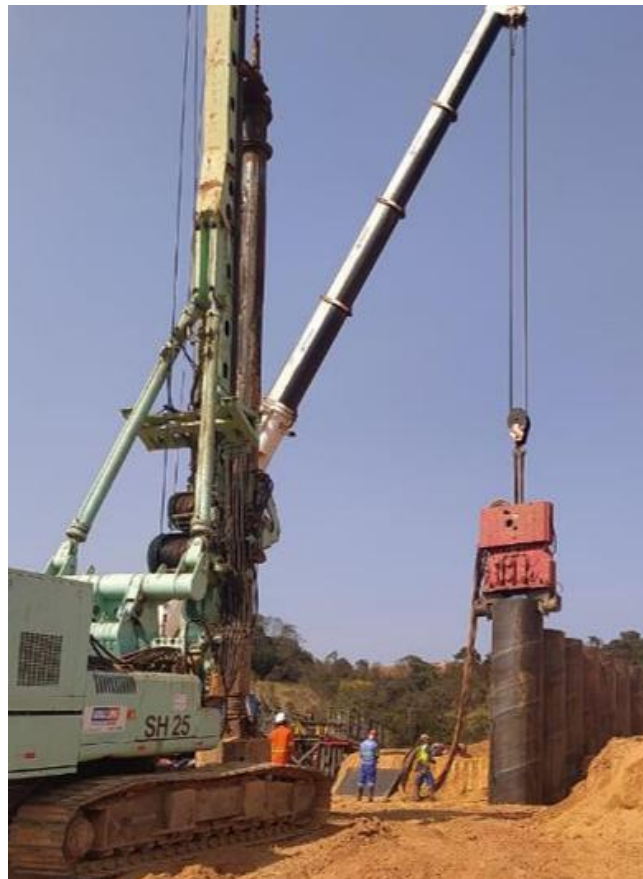
Figura 8– Cravação de estaca metálica com martelo vibratório.
