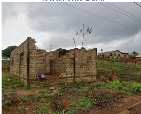
Figura 40 - Edificação abandonada no loteamento Buriti
