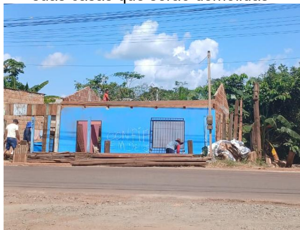
Figura 53 – Mutirão de moradores para aproveitar materiais de construção das suas casas que serão demolidas
