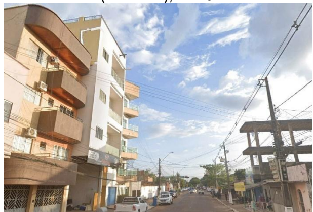
Figura 36 - Edificações sem recuo (a esquerda) e estrutura construtiva inacabada (a direita), Av. José Porfirio
