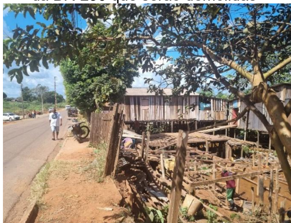
Figura 52 – Tipologia das habitações em palafitas sob curso d'água e próximo da BR-230 que serão demolidas
