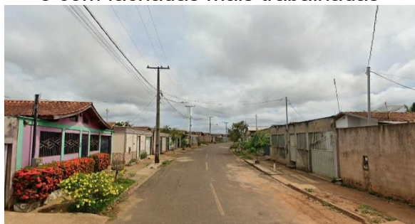
Figura 43 - Rua Capim Limão, RUC São Joaquim, repleta de casas muradas e com fachadas mais trabalhadas
