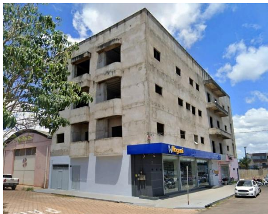
Figura 35 - Edifício Inacabado em via comercial relevante, Av. Brigadeiro
