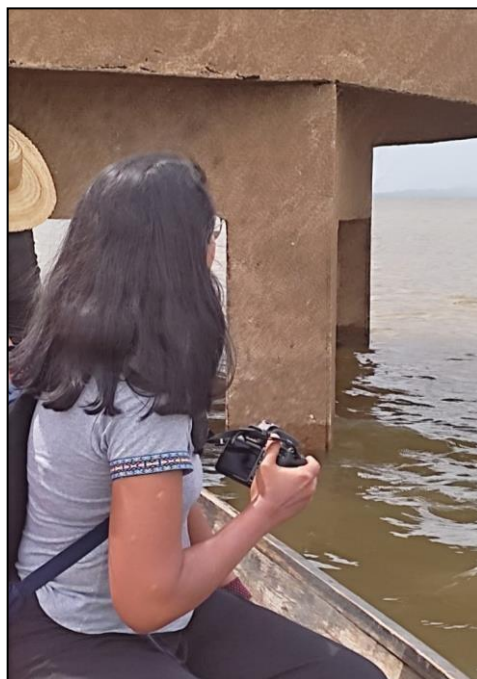
FIGURA 17 - ESTRUTURA DA CAIXA D'ÁGUA DA VELHA JACUNDÁ
