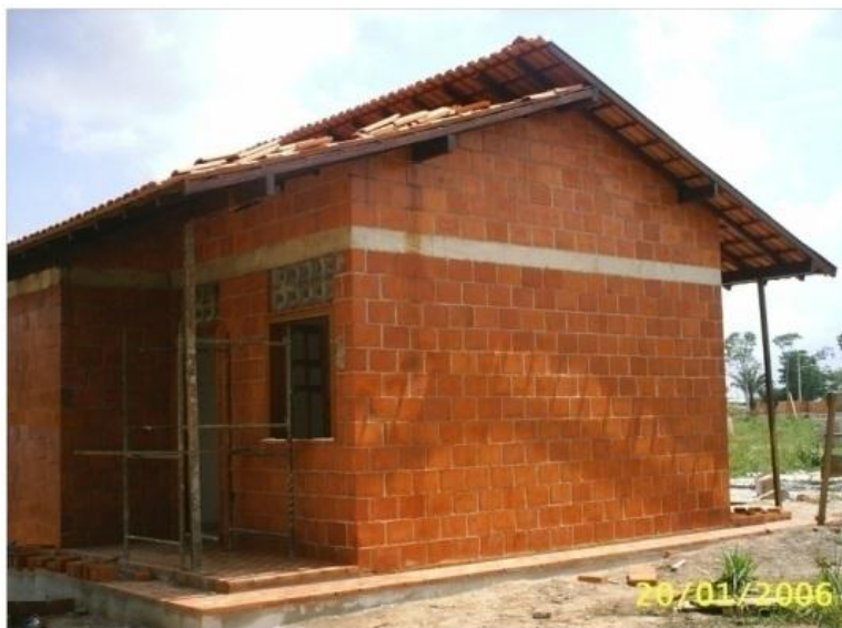
Figura 2.8 - Casa construída com resíduo do processo Bayer. Fonte: SOUZA et al. (2006).
