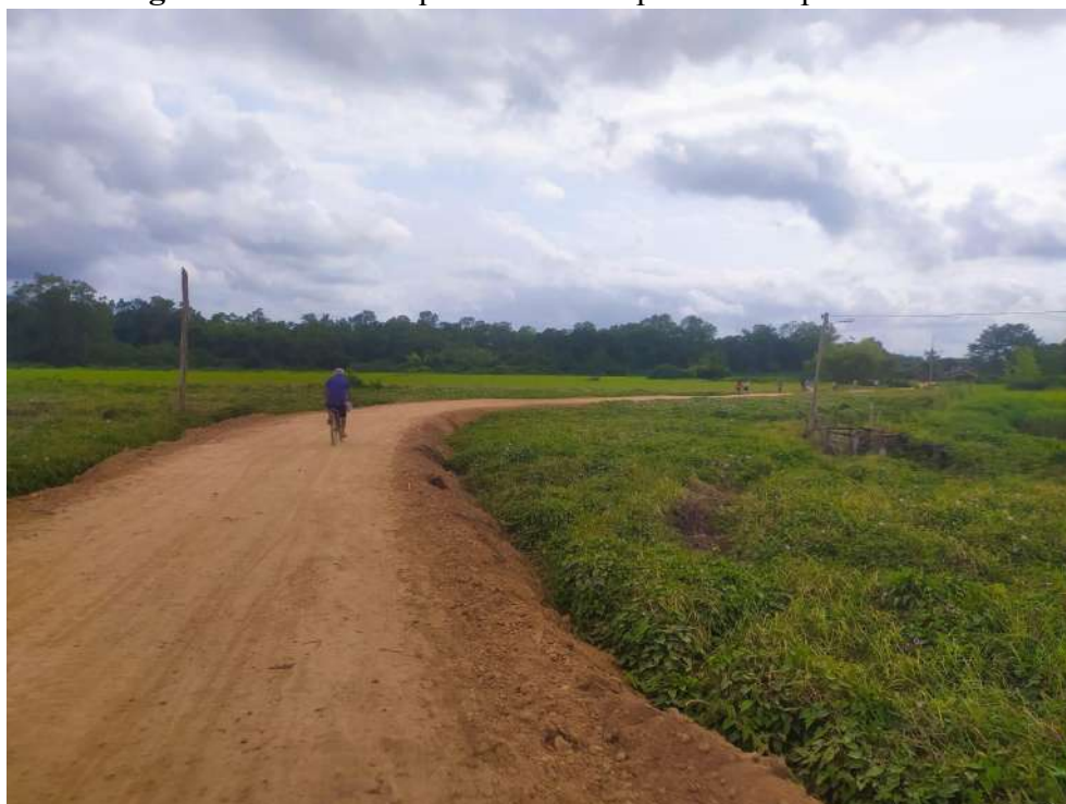
Figura 60 – Estrada que substituiu a ponte na Itapuá de Fora
