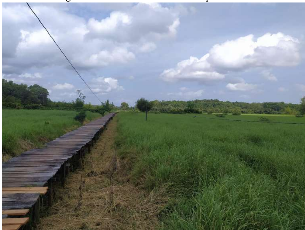
Figura 59 – Ponte de Madeira em Itapuá de Fora
