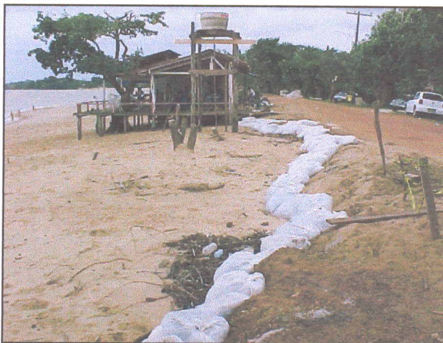
Fig.13. Sacos de areia colocados para conter o avanço da maré na estrada (praia do Paraíso, março/2001).
