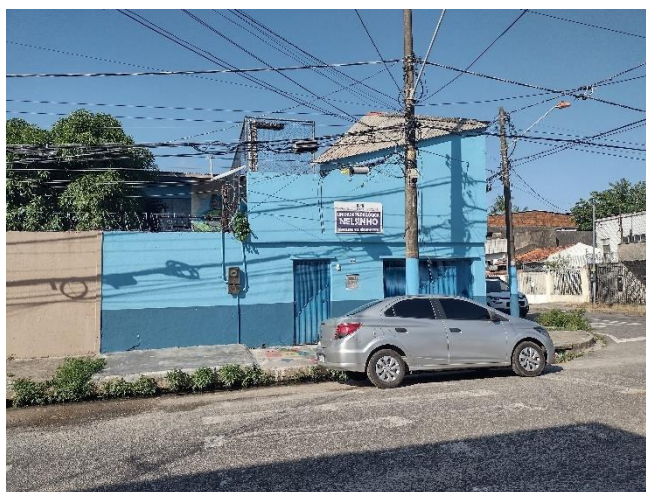
Figura 10 - Fachada da Unidade Educativa C
