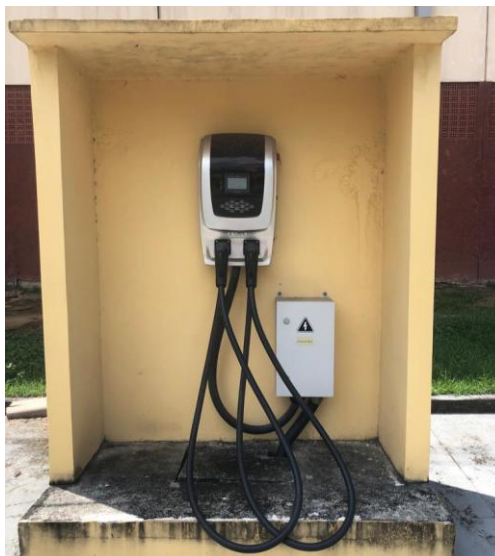
Figura 28 - Eletroposto BYD modelo EVA080KI/01 do Ginásio.
