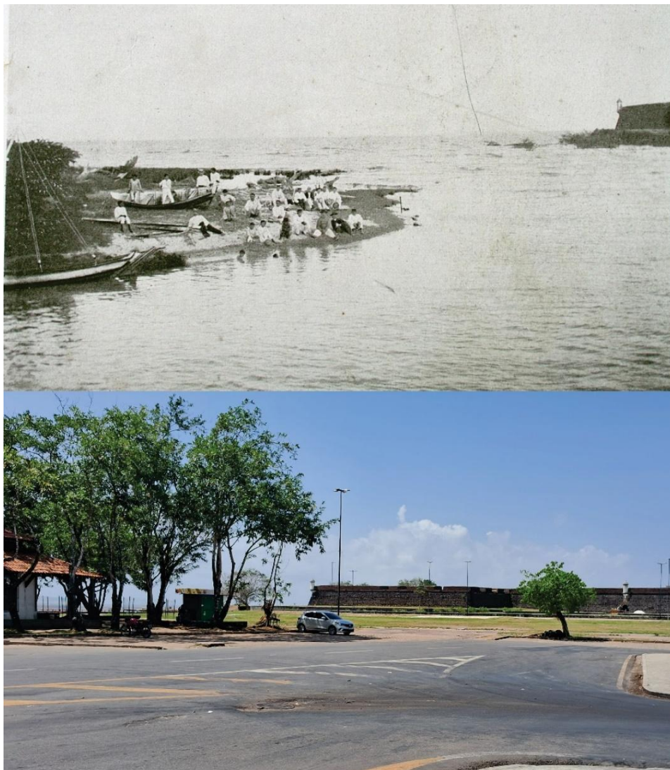
Figura 30 - Montagem com fotografias que mostram o antes e depois do aterramento e canalização do igarapé da Fortaleza.
