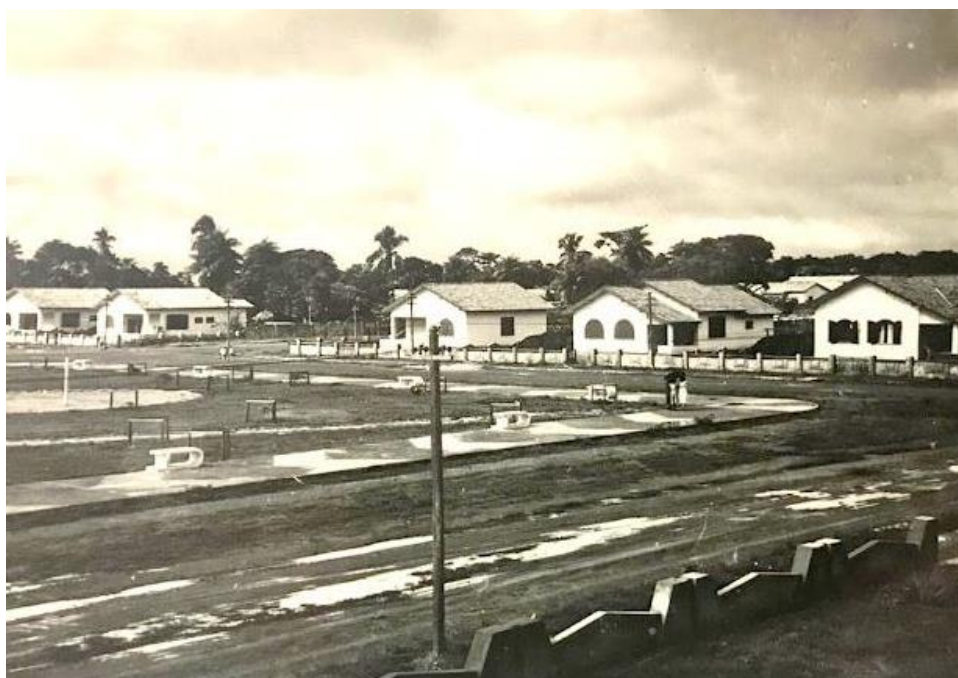
Figura 21 - Casas construídas para os servidores do Governo Janary Nunes em frente à Praça Barão do Rio Branco, 1951.
