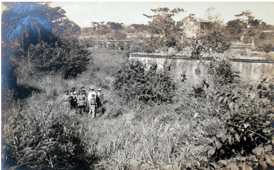
Figura 17 - Fortaleza de São José em situação de abandono na década de 1930.
