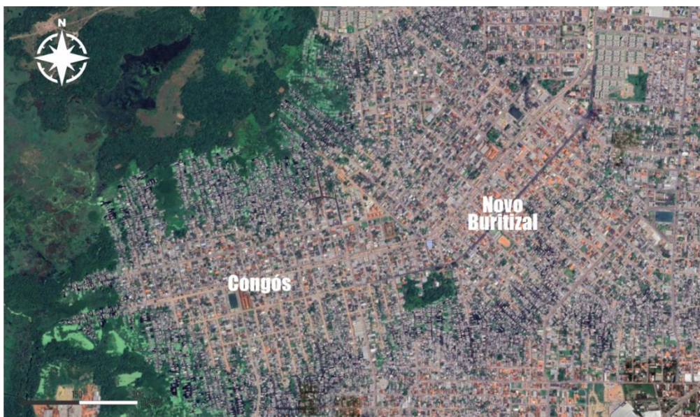
Figura 43 - A diferença na malha urbana entre a ocupações em terra firme e em áreas de ressaca nos bairros Congós e Novo Buritizal.
