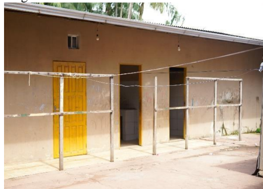
Figura 6- vista externa dos banheiros
