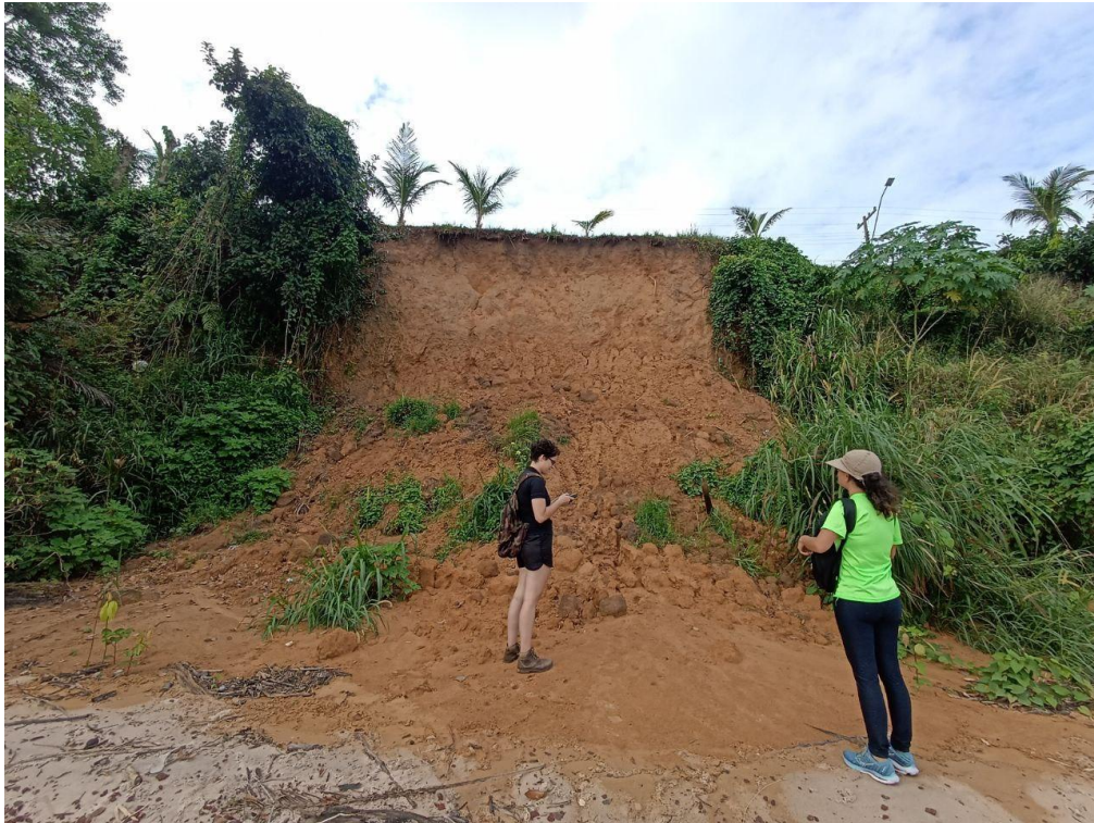
Fotografia 12 - Ponto 5: Erosão e Deslizamento de Encosta.
