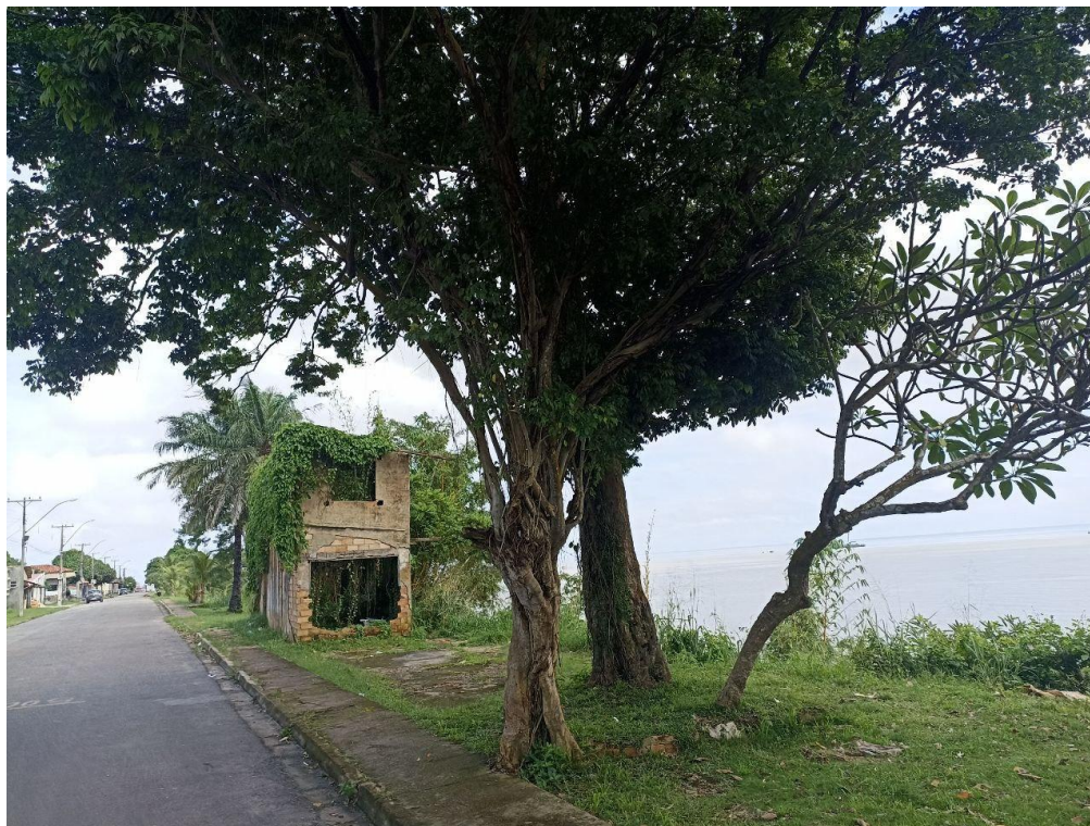
Fotografia 20 - Ponto 10: Antiga Residência
