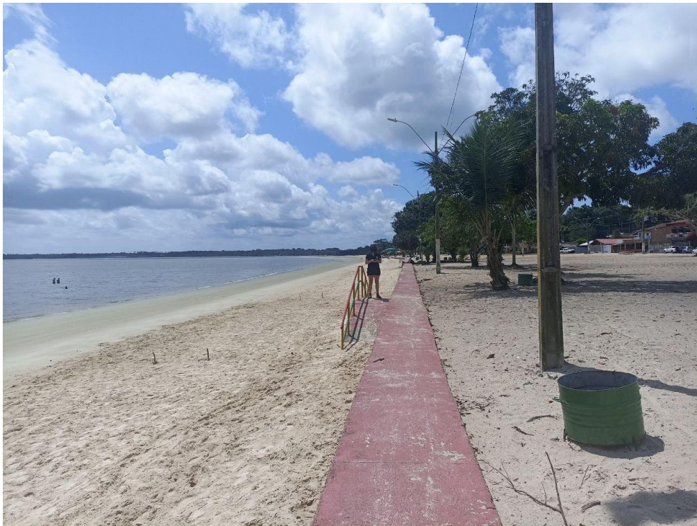
Fotografia 25 - Contenção na praia do Caripi
