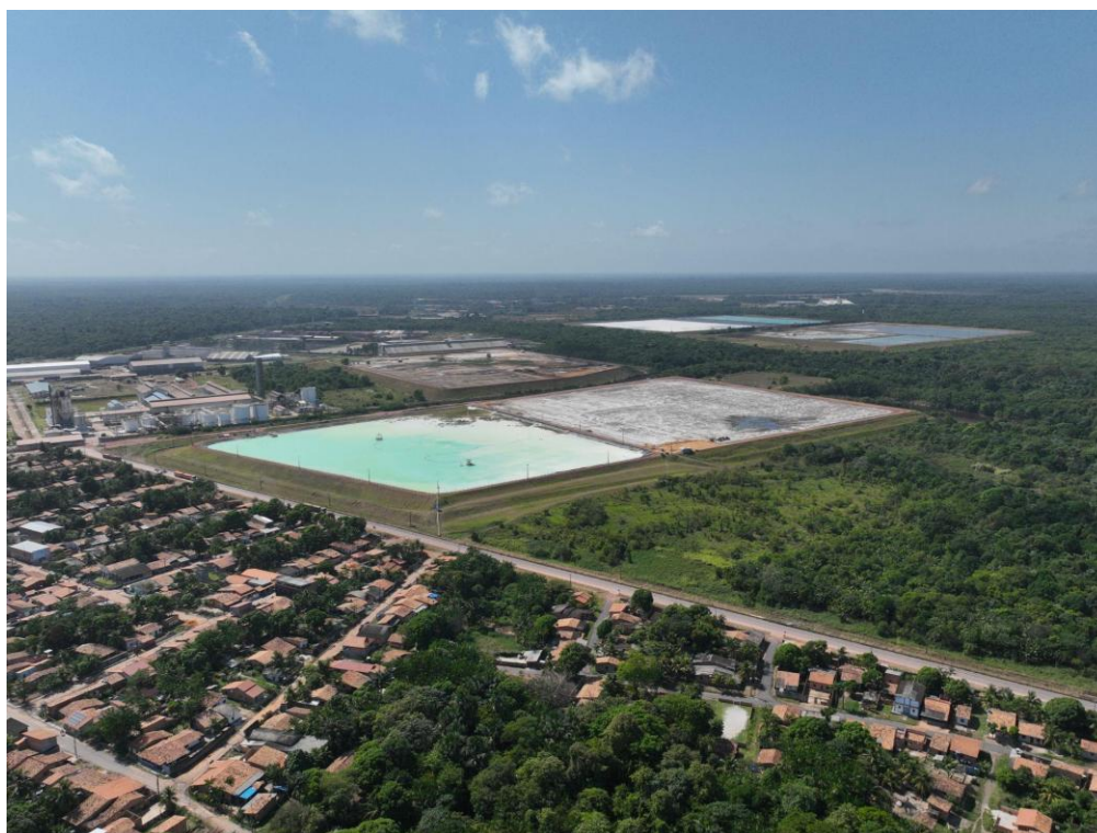
Fotografia 37 - Barragens de rejeito de caulim
