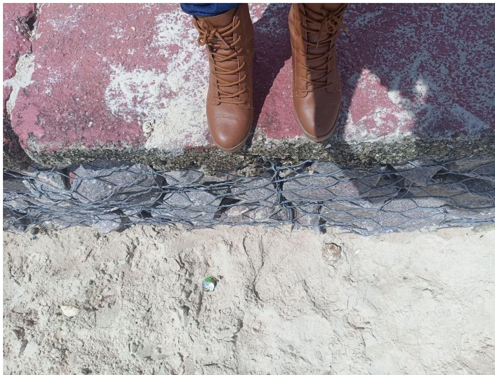
Fotografia 26 - Muro de Arrimo
