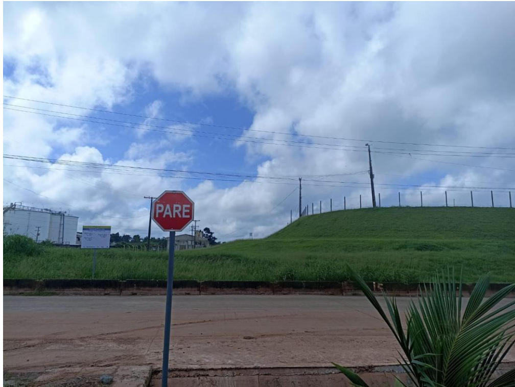
Fotografia 2 - Ponto 1: Base da Barragem nº 3 (B3)
