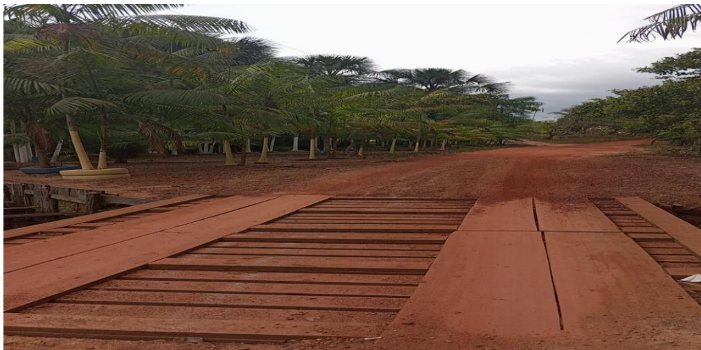
Figura 5 - Imagem atual da entrada da vila Tauari.
