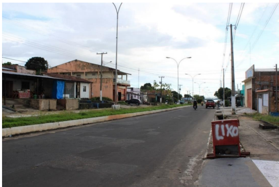
Fotografia 37: Travessa Carlos Maria Teixeira com pavimentação e meio fio.
