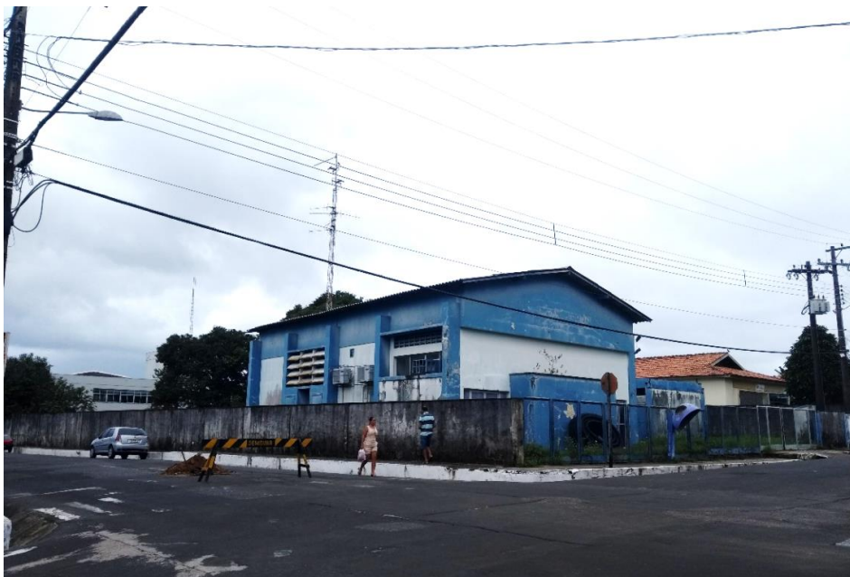
Fotografia 60: Estação de telecomunicação com torre e administração novas.
