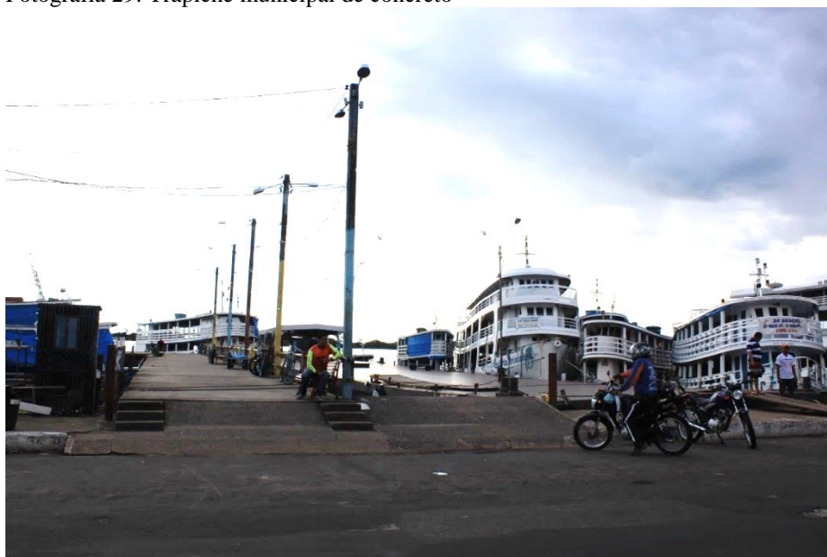
Fotografia 29: Trapiche municipal de concreto
