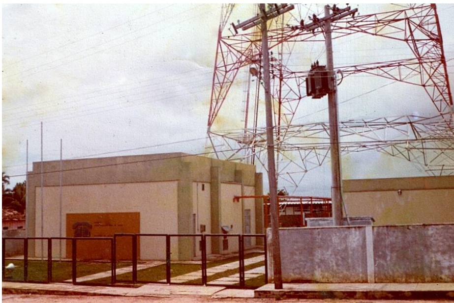
Fotografia 59: Estação de telecomunicação, anos 1980.
