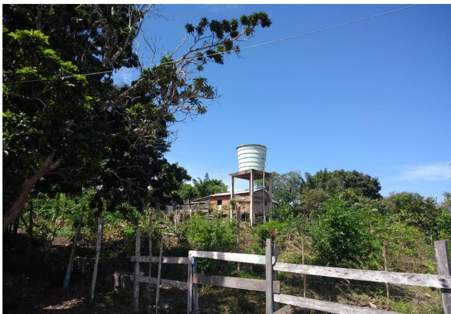
Fotografia 54: Melhorias no saneamento básico (Comunidade Ascensão).
