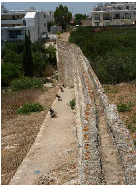
Figura 5 - Aqueduto em Agia Napa, Chipre
