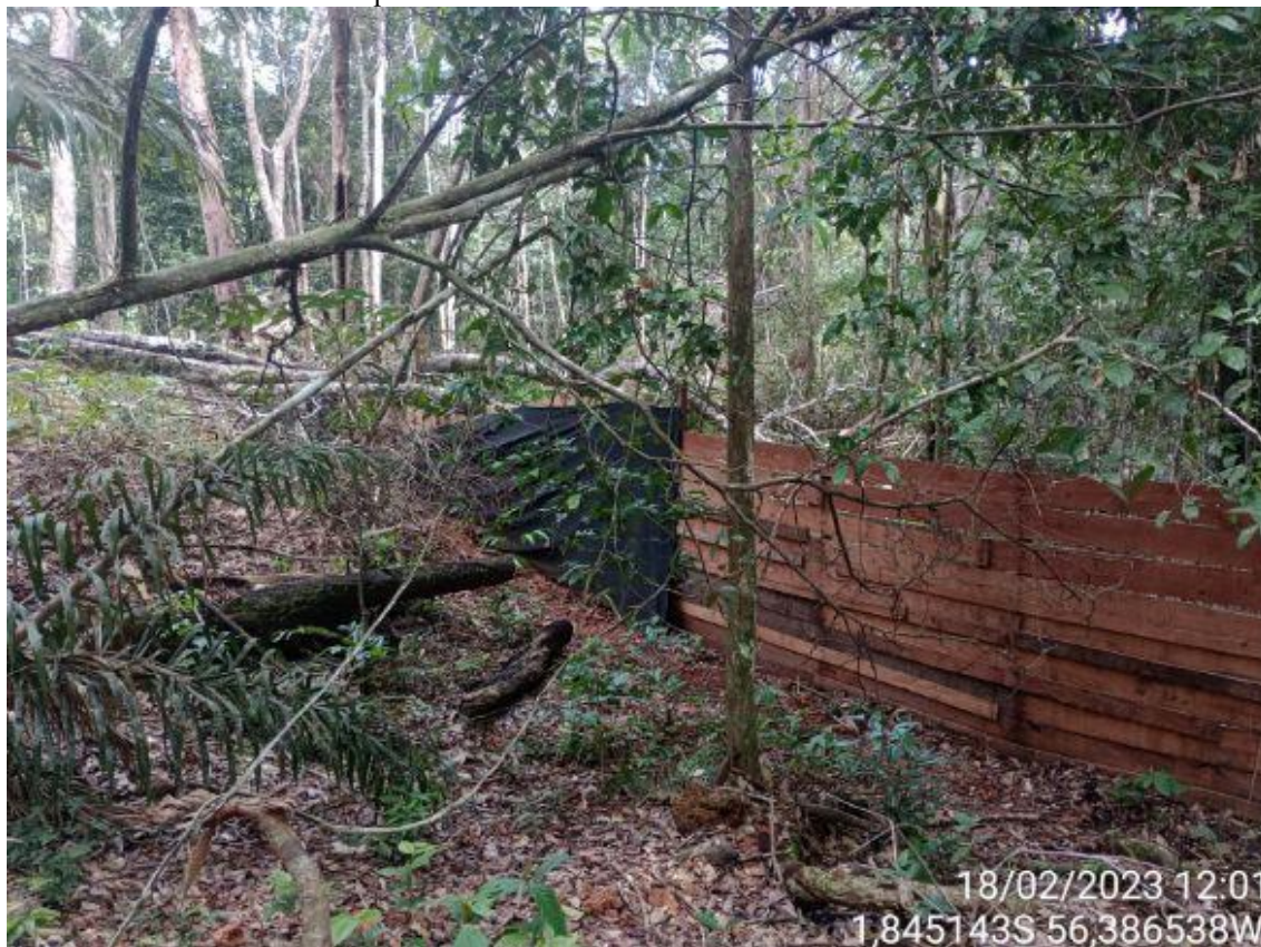
Figura 48 — Parede de madeira construída, pela empresa, em terreno menos íngreme, para conter o alcance da lama oriunda de possíveis novos deslizamentos da encosta da serra do Aramã.
