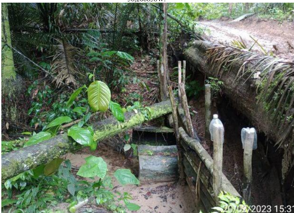
Figura 77 — Ângulo lateral da ponte construída sobre igarapé. Coordenadas Geográficas: 1,668033S 56,206858W.
