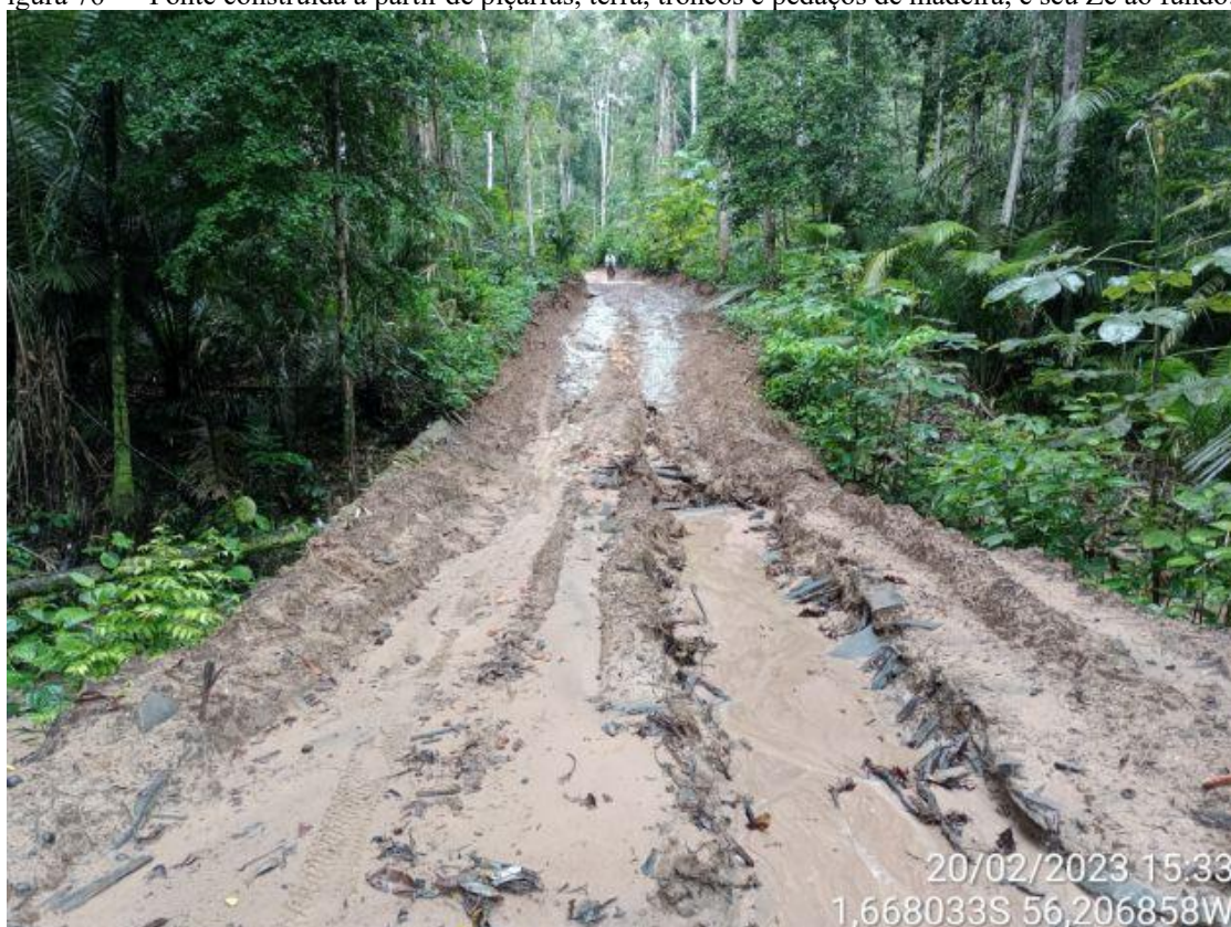
Figura 76 — Ponte construída a partir de piçarras, terra, troncos e pedaços de madeira, e seu Zé ao fundo.
