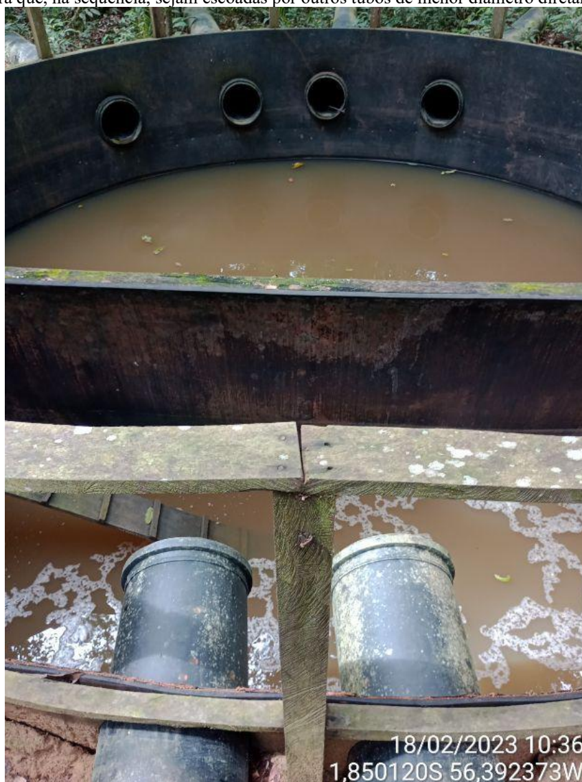
Figura 34 — Detalhe do local em que as águas acumuladas no dreno, localizado no alto do platô, são armazenadas para que, na sequência, sejam escoadas por outros tubos de menor diâmetro diretamente na floresta.
