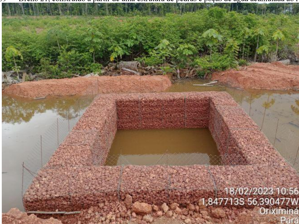
Figura 39 — Dreno 21, construído a partir de uma estrutura de pedras e poças de água acumulada ao redor.
