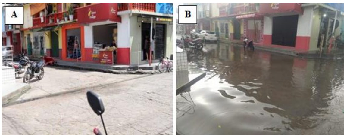
Figura 2 - Condições de drenagem da água pluvial na área urbana central de Vigia de Nazaré. (A) Ambiente sem chuva registrado no dia 15 de abril de 2023 e (B) ambiente totalmente inundado após fortes chuvas ocorridas no dia 02 de fevereiro de 2023, durante período chuvoso.
