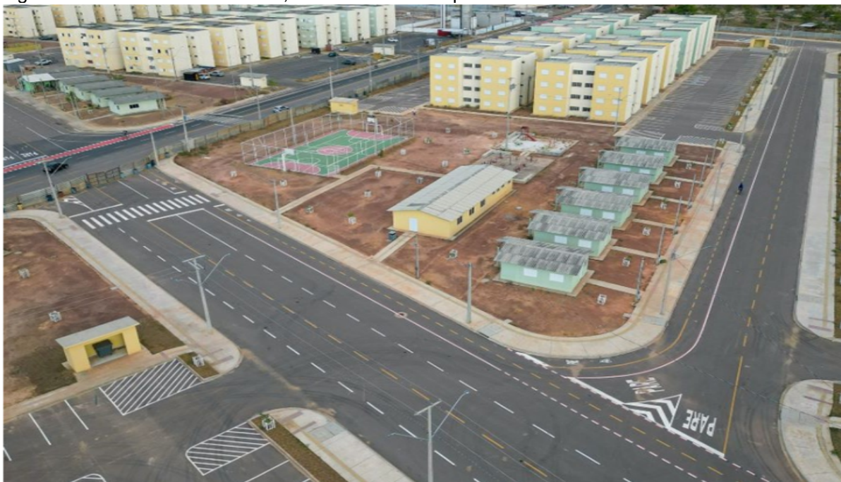
Figura 14 - Residencial Miracema, na cidade de Macapá/AP
