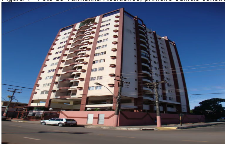
Figura 4 - Foto do Turmalina Residence, primeiro edifício construído em Macapá acima de 10 andares
