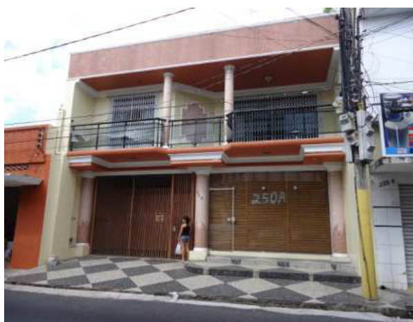
Figura 29: Arquitetura classificada como destoante, destaque para os materiais e formas empregadas na fachada.
