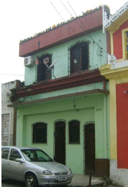
Figura 13: Edificação com uso de habitação multifamiliar, a nova pintura destacou a cimalha que se prolonga ao imóvel seguinte. Foto: Dinah Tutya, 2011.
