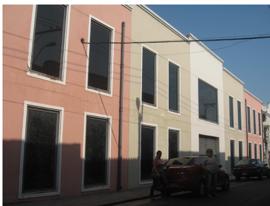
Figura 6: Conjunto de fachadas, edificadas na Rua Dr. Assis, as quais não estão em uso.
