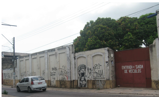
Figura 11: “Esqueletos” das antigas edificações que hoje constituem o muro lateral do Colégio do Carmo.
