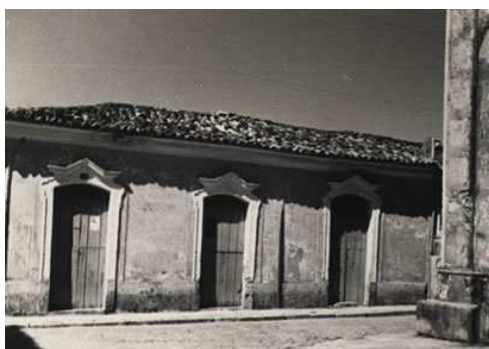
Figura 41: Edificação na Rua Dr. Malcher, registrada por Robert Smith entre os anos 37 a 47.
