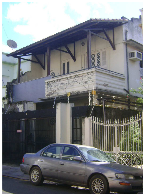
Figura 53: foto atual da fachada, com os acréscimos feitos na reforma dos anos 90, colocação da cobertura na varanda do pavimento superior, projeção do arco em um volume, revestimento em pastilha de parte do guarda corpo e a elevação do muro e colocação da grade. Foto: Dinah Tutya, 2012.
