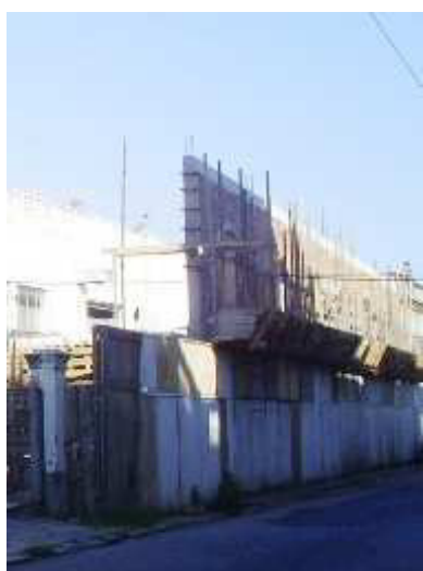
Figura 26: Imagem da construção que estava sendo realizada no conjunto que hoje se encontra com as feições da figura 28. Foto: acervo Fórum Landi, 2006.
