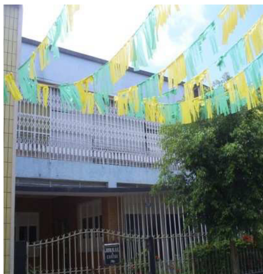
Figura 37: Imóvel de tendência modernizante da arquitetura, como o recuo frontal, a presença de pátio, a ausência de ornamentação, além do uso dos materiais e da composição da fachada. Foto: Dinah Tutya, 2012.
