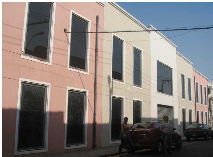
Figura 28: Novas fachadas construídas, entre o ano de 2006 à atualidade. Composição totalmente diferente da anterior. Foto: Dinah Tutya, 2012.
