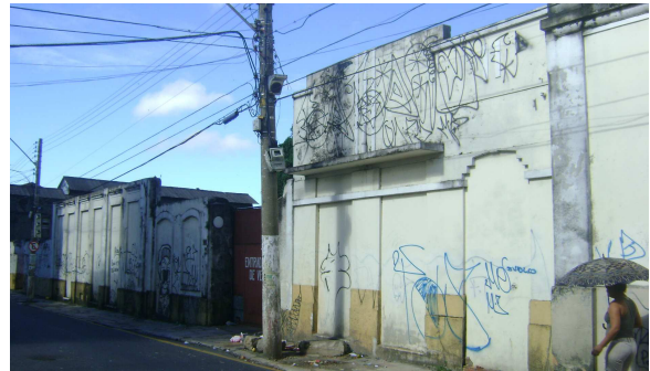
Figura 65: Foto atual do trecho da figura anterior, após a compra das casas pelo Colégio do Carmo. Foto: Dinah Tutya, 2012.
