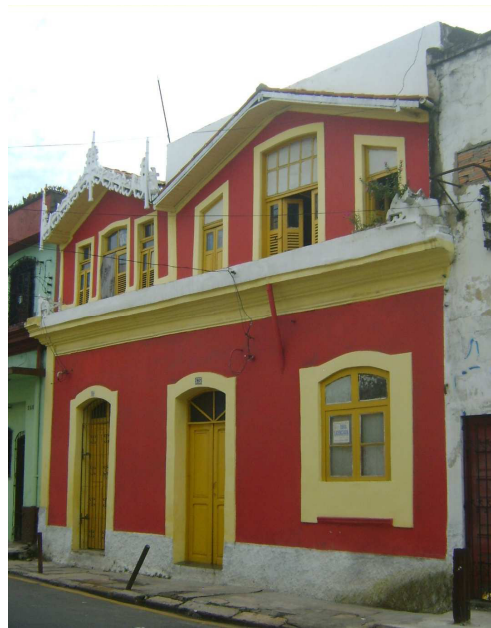
Figura 14: Imóvel com uso habitacional multifamiliar, no qual a pintura com as cores fortes possibilitaram uma nova leitura da fachada. Foto: Dinah Tutya, 2011.
