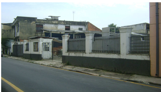
Figura 72: Área do antigo Supermercado Y.Yamada, denominado por “atacadão Yamada” por alguns moradores. O local atualmente funciona como depósito, porém os moradores não sabem informar precisamente o uso. Segundo a fala dos moradores, neste espaço nunca houve edificações. Foto: Felipe Moreira, 2012.
