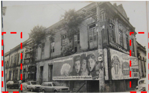
Figura 55: Edificação da Rua João Diogo, de esquina com a Rua Angelo Custódio, destaque para a feição dos imóveis marcados. Fonte: acervo IPHAN-IBPC, 1992.
