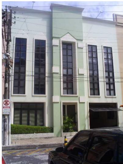
Figura 4: Edificação ocupada pelo poder judiciário, se encontra localizada no entorno da Igreja de São João dentro do Bairro da Cidade Velha. Esta área é hoje identificada como “setor judiciário”, em decorrência da quantidade de imóveis que abrigam este serviço. Foto: Fórum Landi, 2006.
