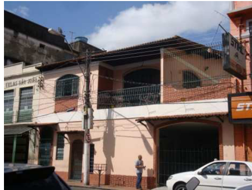
Figura 20: Imóvel classificado como sem aparência do bairro da Cidade Velha, a garagem foi o elemento fundamental para tal categorização.
