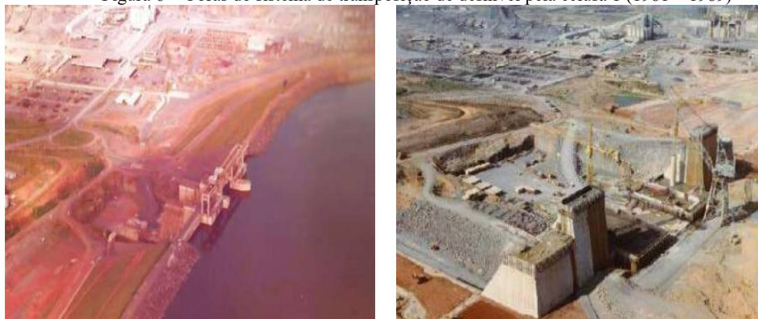
Figura 6 – Obras do sistema de transposição de desnível pela eclusa 1 (1981 – 1989)
