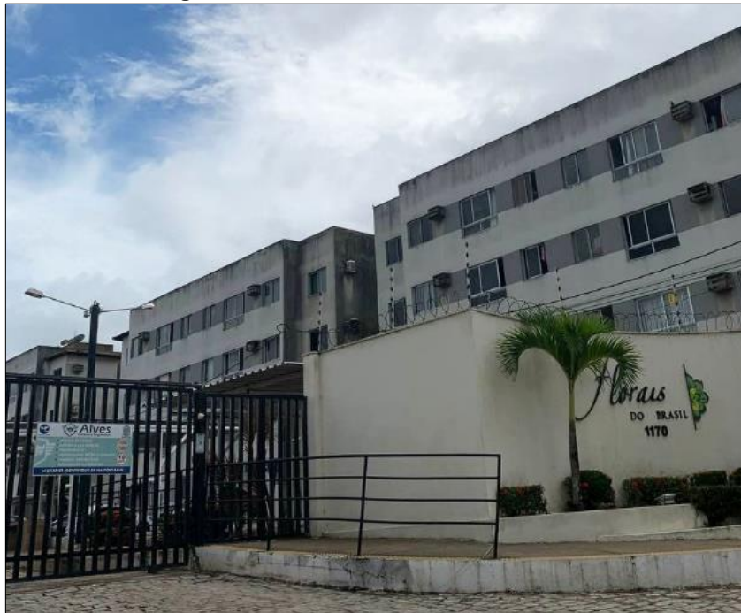
Figura 19 – Fachada do condomínio Florais do Brasil.
