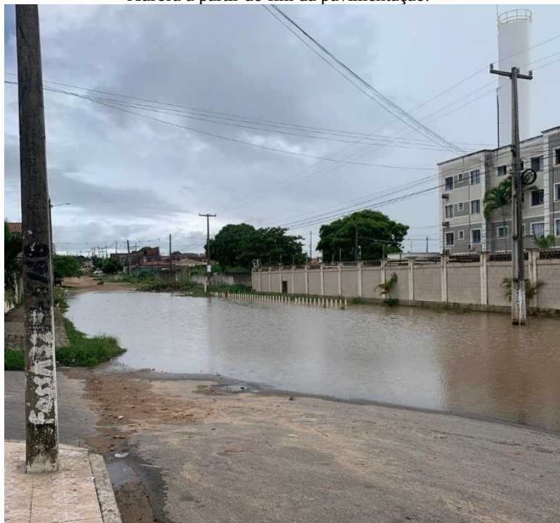
Figura 34 – Acúmulo de águas pluviais na rua do Condomínio Nova Aurora a partir do fim da pavimentação.
