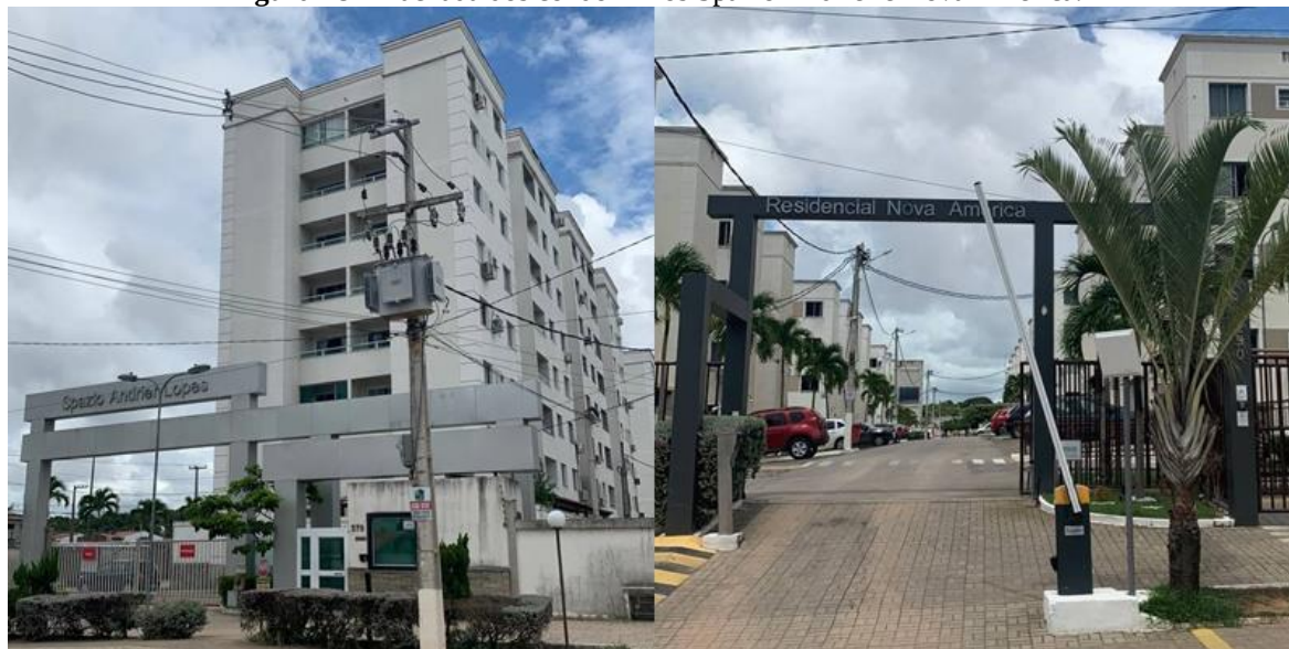
Figura 18 – Fachada dos condomínios Spazio Andrier e Nova América.
