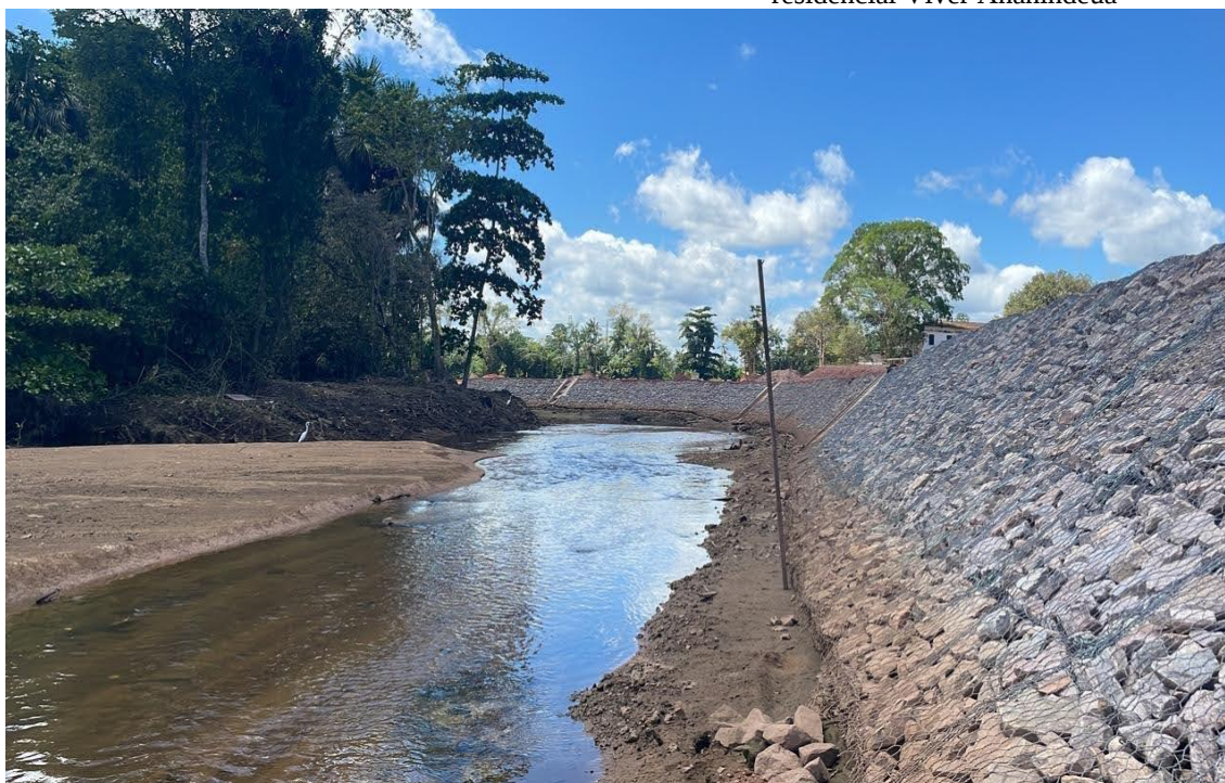
Figura 50 : Vista do Rio Maguari e obras no futuro Parque
