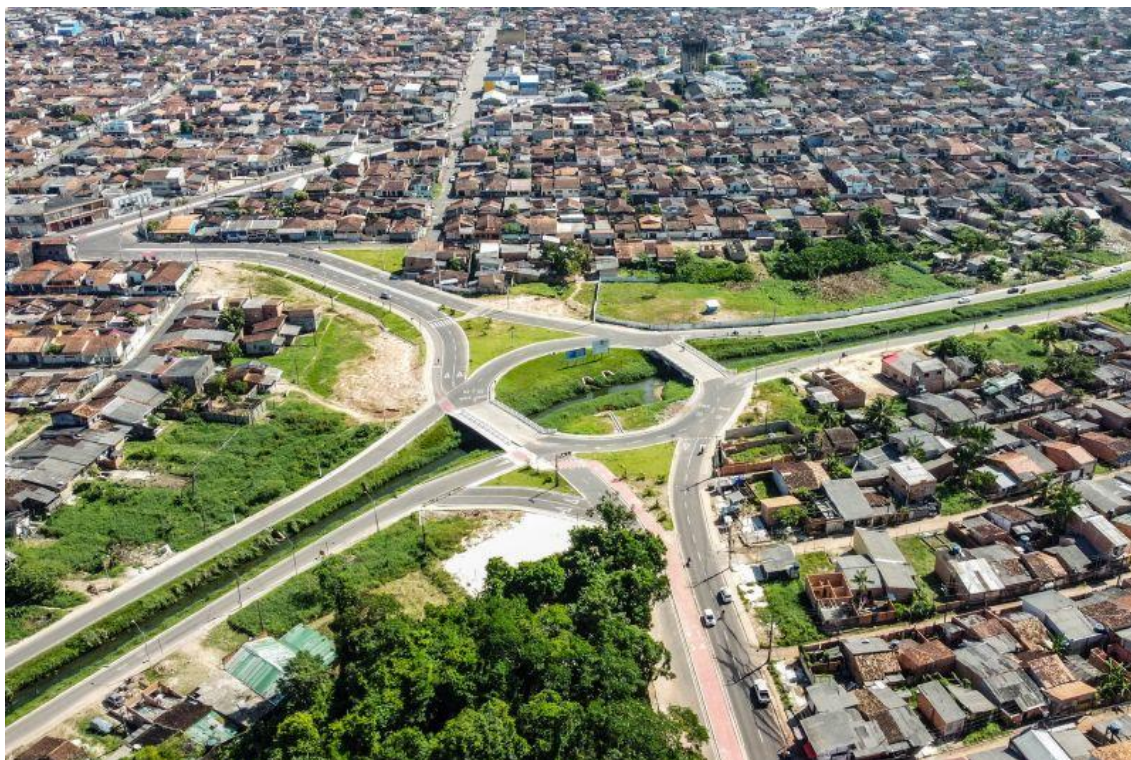
Figura 54: Rua Ananin e canal Maguariaçu Fonte: agenciapará, 2023.
