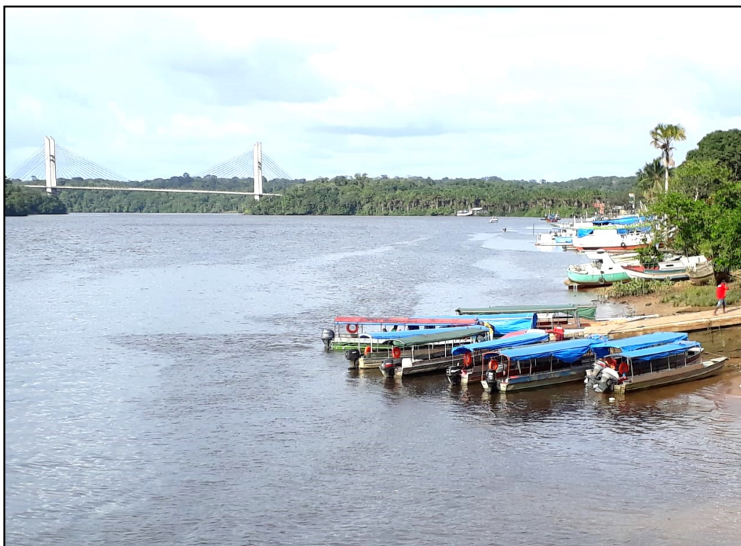
Imagem 8 - A fronteira Franco-brasileira oficialmente delimitada pelo talvegue do Rio Oiapoque, em município homônimo. Ao fundo, a ponte estaiada binacional.
