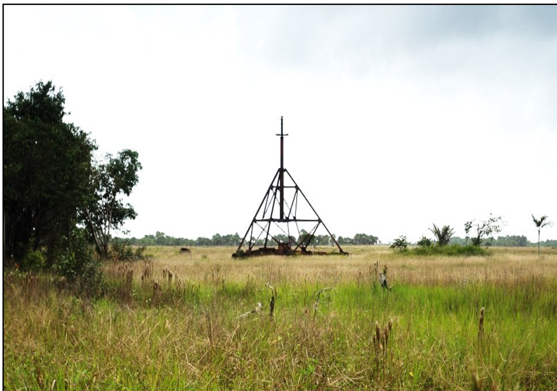
Imagem 53 - Atracadouro de Zepelim constante das ruínas da BAA, município de Amapá/AP Fonte: (Fratius 2021).
