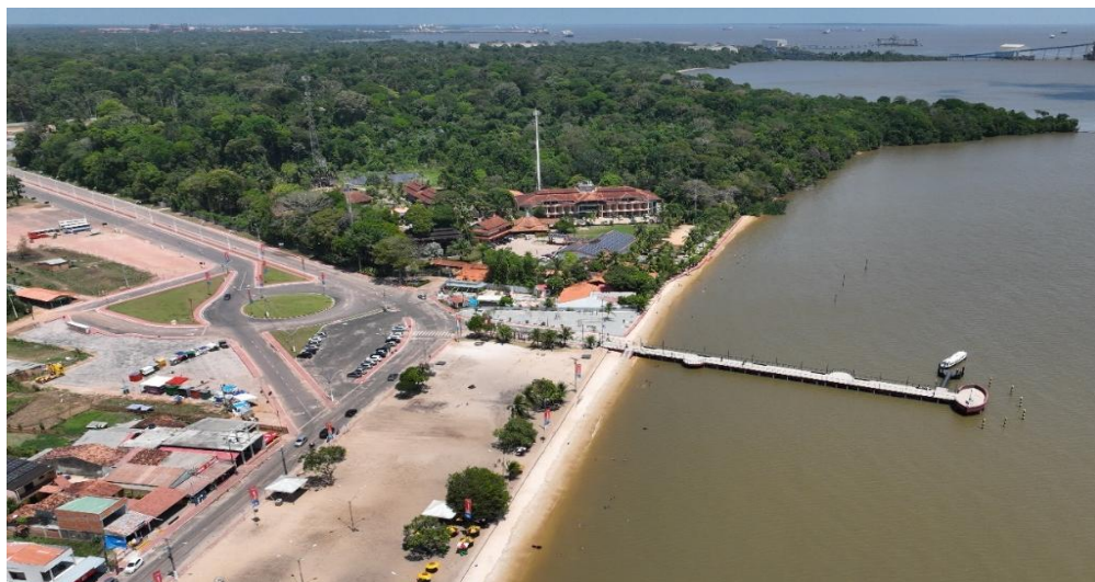
Figura 16: Orla da praia do Caripi em Barcarena-PA, e próximo ao trapiche fica localizado o hotel.
