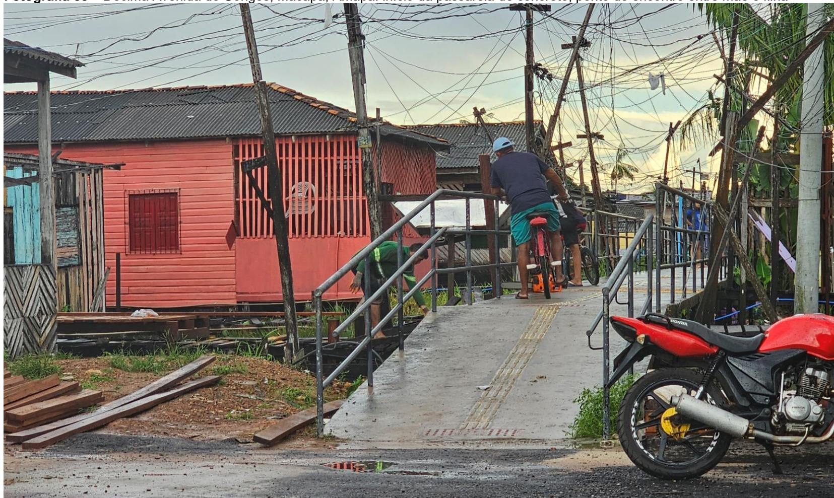
Fotografia 55 – Décima Avenida do Congós, Macapá, Amapá: início da passarela de concreto, ponto de encontro entre mãe e filha
