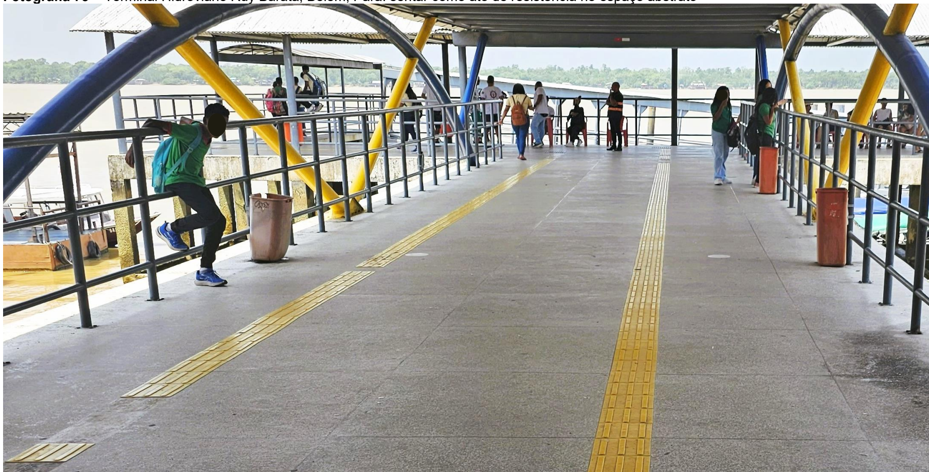
Fotografia 73 – Terminal Hidroviário Ruy Barata, Belém, Pará: sentar como ato de resistência no espaço abstrato
