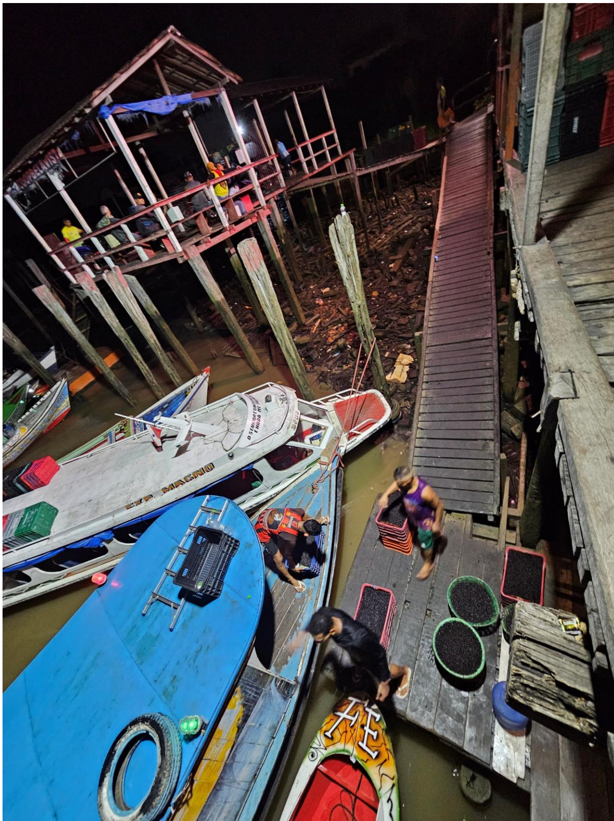
Fotografia 65 – Porto da Palha, Belém, Pará: plataforma fixa que conecta a rampa e a escada ao nível mais baixo da estrutura
