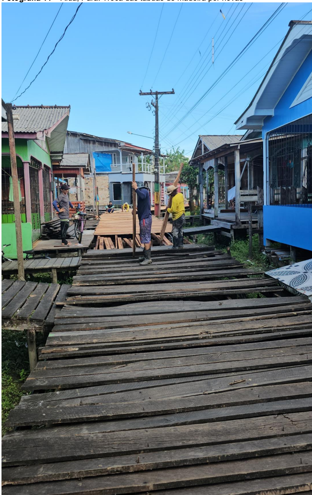
Fotografia 11 – Afuá, Pará: Troca das tábuas de madeira por novas
