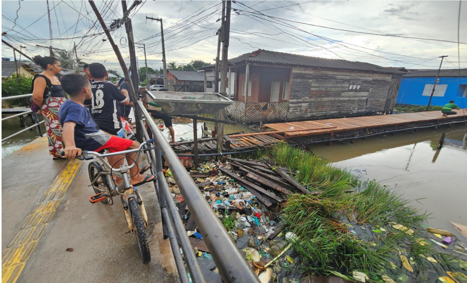
Fotografia 57 – Décima Avenida do Congós, Macapá, Amapá: uso misto de pessoas sobre a passarela de concreto
